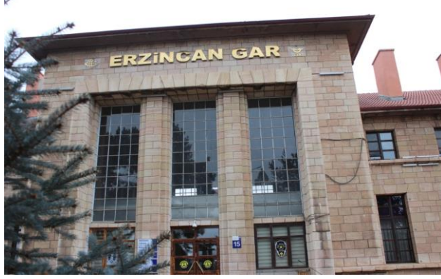
Fotoğraf 13: Erzincan Gar Binası giriş kapısı
