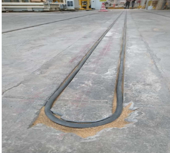
Şekil 3.9. Kablonun serilmesi
