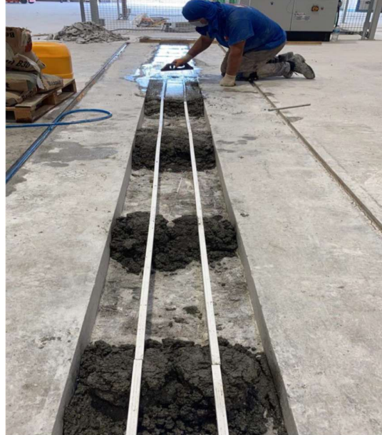
Şekil 3.7. Kablo kanallarının oluşturulması
