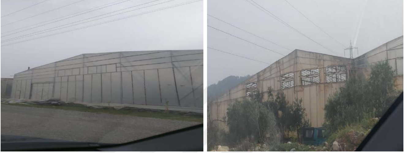
Bozyazı İlçesi'nden üçgen çatılı seranın görünüm
