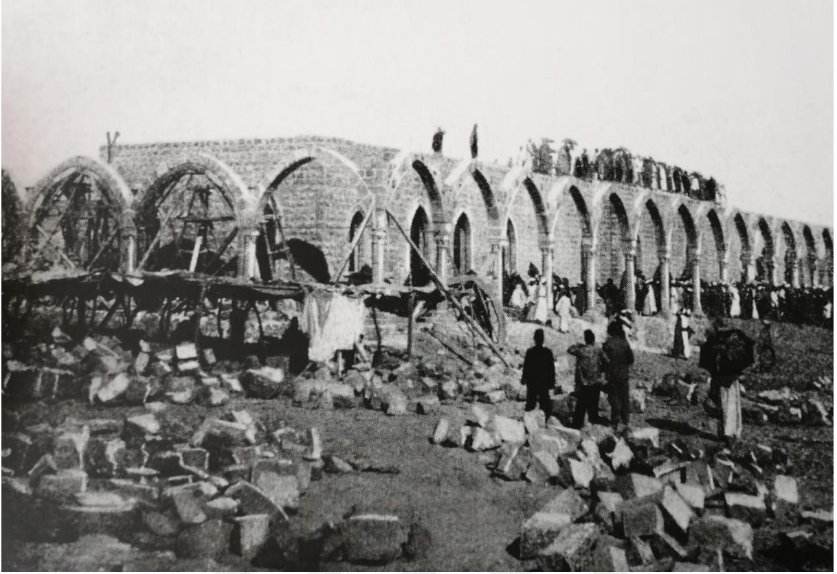
Ek XIV – Hicaz Demiryolu’nun Medine-i Münevvere gar binasının inşaatı. (Yılmaz, a.g.e, s. 27.)
