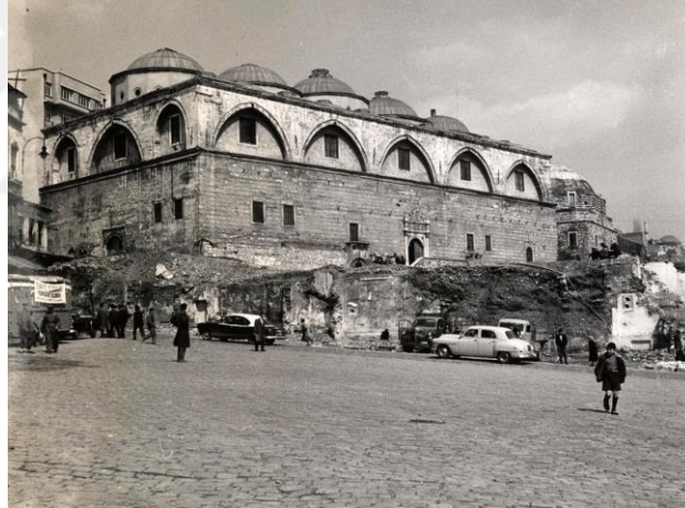
Şekil 2.6: İstanbul Tophane-i Amire binası (URL-6, 2021).
