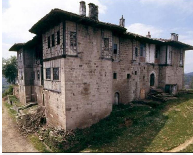
Şekil 2.13: Trabzon Of'ta bulunan Çakıroğlu İsmail Ağa konağının restorasyon çalışmaları başlamadan önceki hali (URL-13, 2021).
