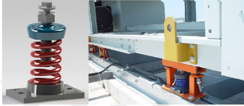
Şekil 5.7. Makine montajı için helisel yay izolatörü
