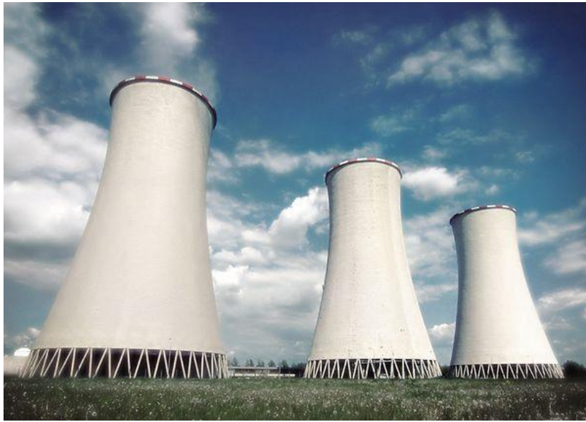
Şekil 3.4. Doğal çekişli soğutma kulesi görünümü (URL-5)
