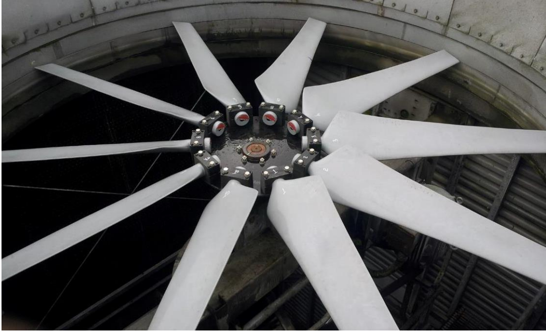
Şekil 4.2. Epoksi fiber glass aksiyel fan görünümü (Encon Group, 2019)
