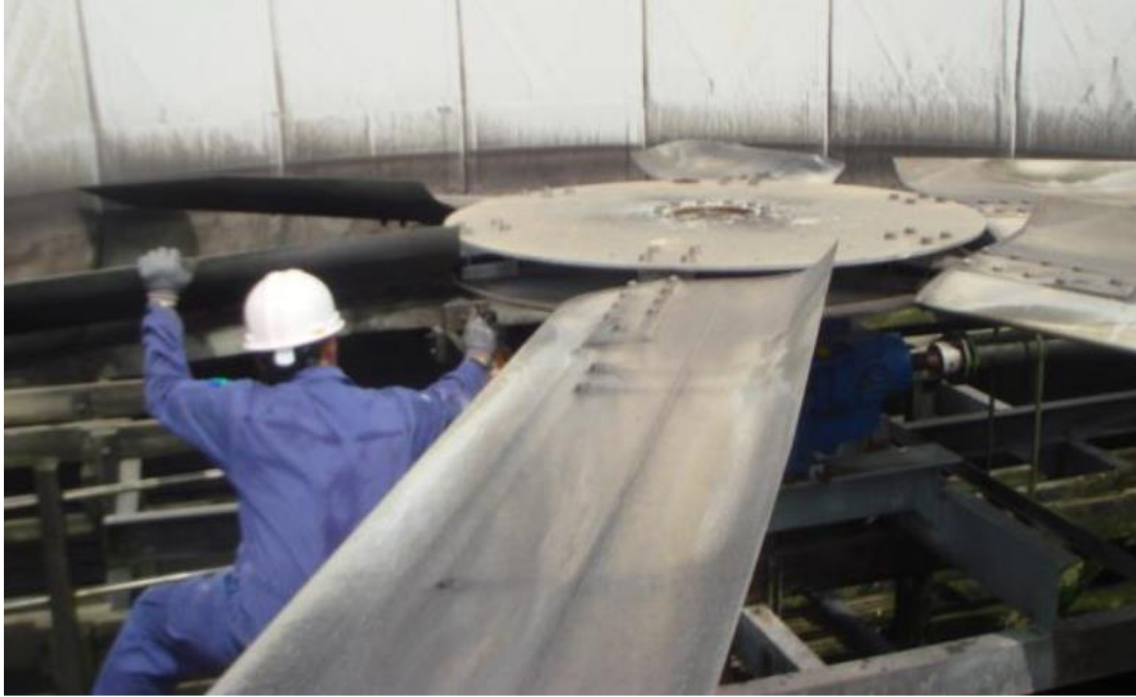
Şekil 6.10. Soğutma kulesindeki alüminyum fan kanatlarının sökülmesi örneği (Encon Group, 2019)
