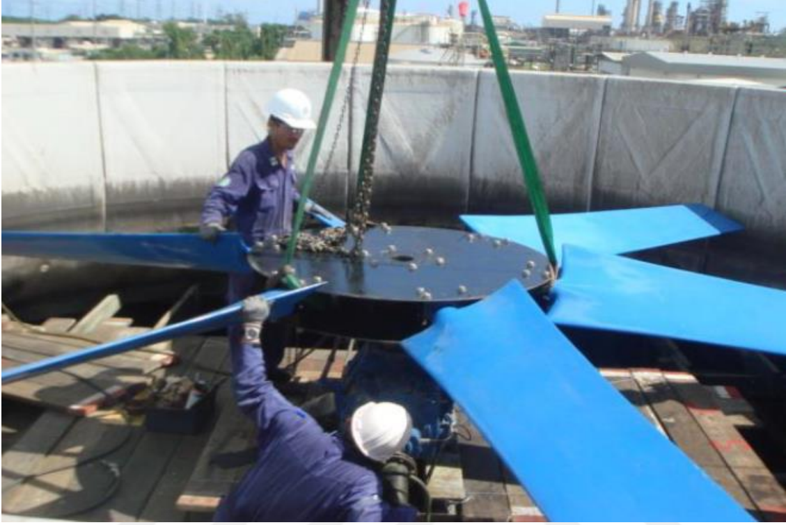
Şekil 6.11. Soğutma kulesindeki epoksi fiber glass fan kanatlarının montajı örneği (Encon Group, 2019)
