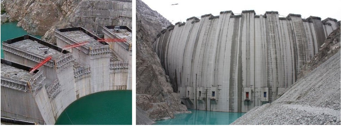
Şekil 3. Beton kemer baraj inşası
