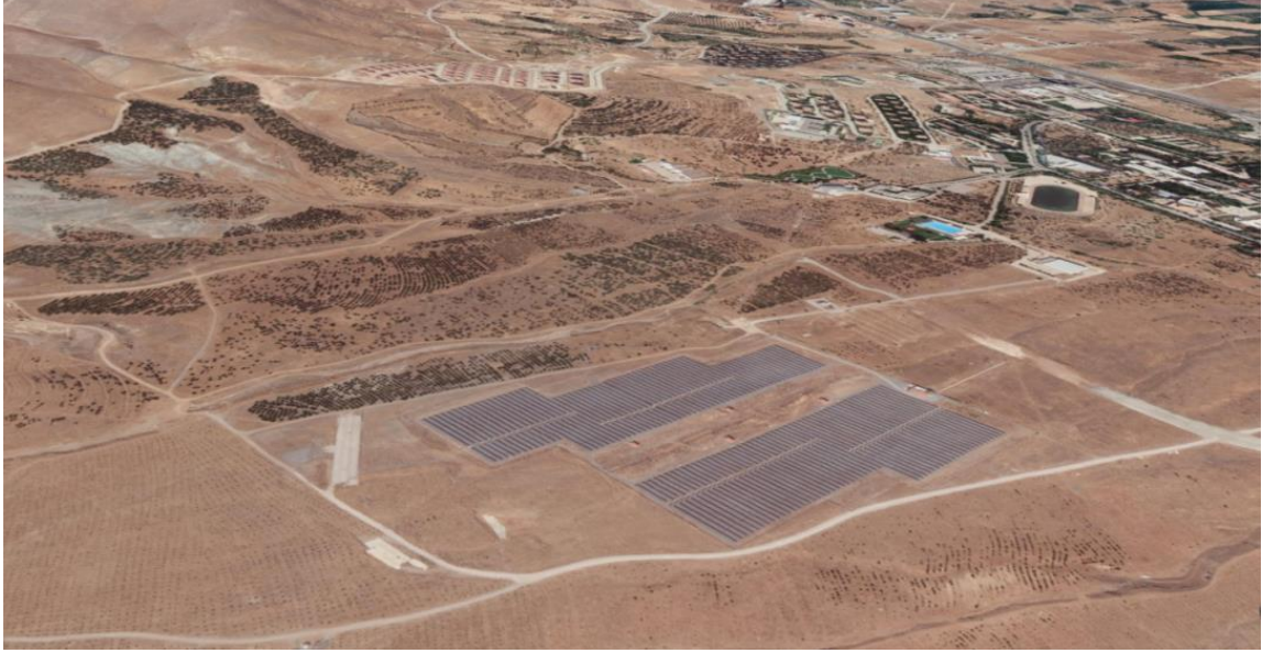
Şekil 2.8. İnönü Üniversitesi güneş enerjisi santrali [25]
