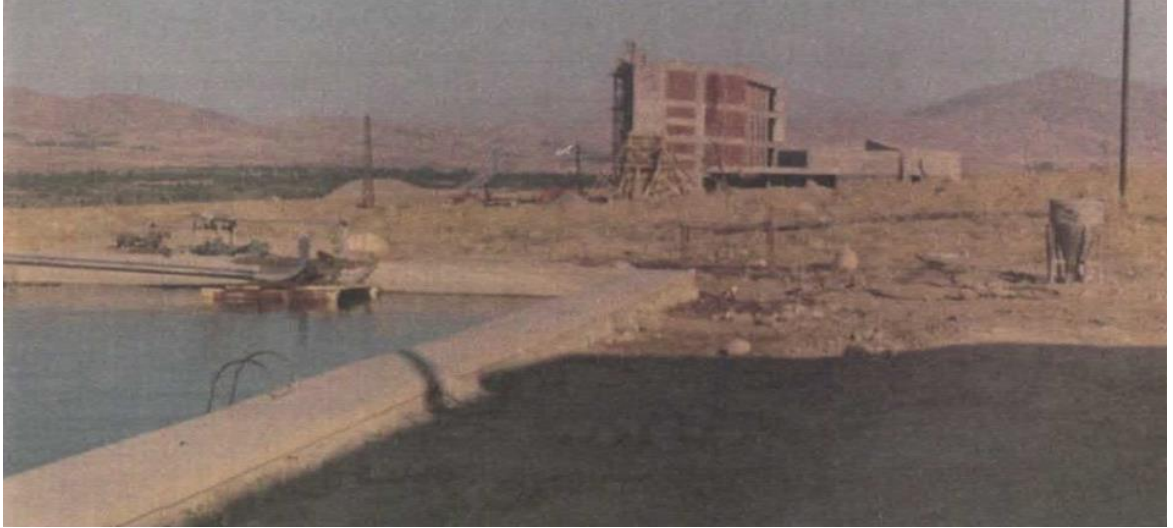
Şekil 4.4. Kampüs Fen-Edebiyat Fakültesi derslikleri inşaatı [27]
