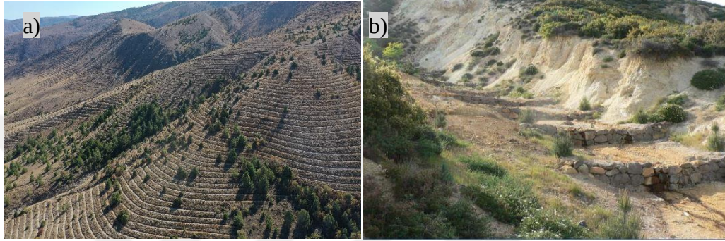
Şekil 4. a) Yüksek eğimli yamaçlarda teraslama ve ağaçlandırma ile erozyon kontrolü, b) Eşik yapısı (DSİ, 2019; URL-3).
