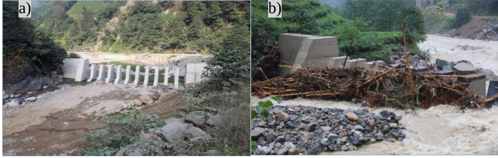
Şekil 6. Beton bir klasik tersip bendi ve önündeki düşü yapısı, Seyitler Köyü, Artvin (URL-4).
