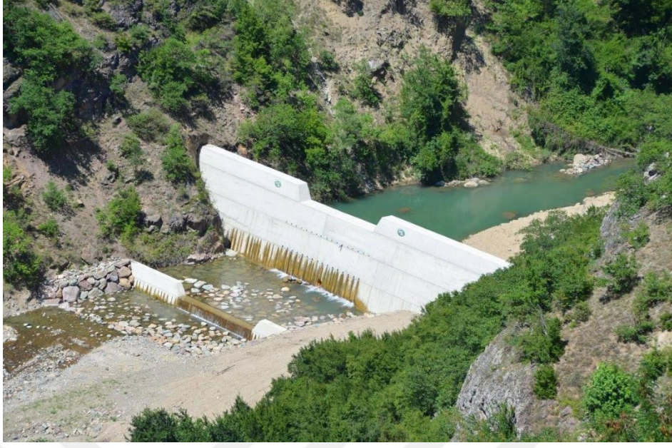
Şekil 6. Beton bir klasik tersip bendi ve önündeki düşü yapısı, Seyitler Köyü, Artvin (URL-4).
