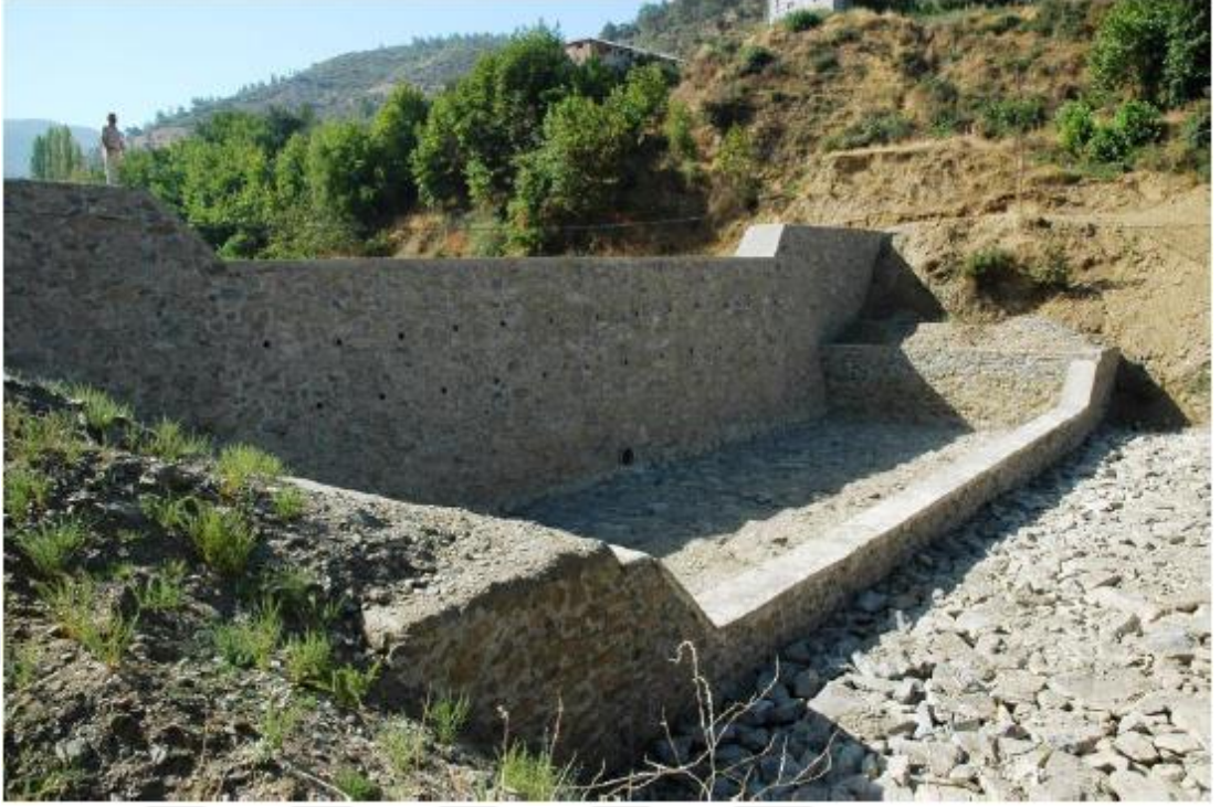
Şekil 5. Düşü havuzlu kargir ıslah sekisi, Irlamaz çayı (Dinçsoy, 2013).
