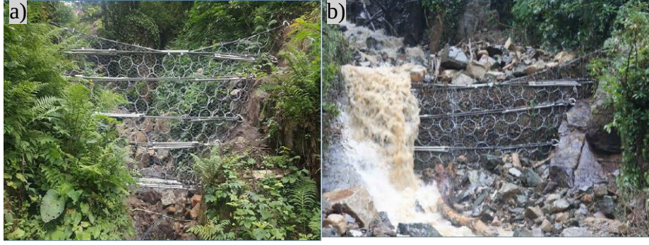
Şekil 8. Güneysu Deresi yan kolu moloz bariyeri a) İlk inşa edildiğinde b) Moloz bariyeri rüsubatla dolduktan sonra (DSİ, 2019).
