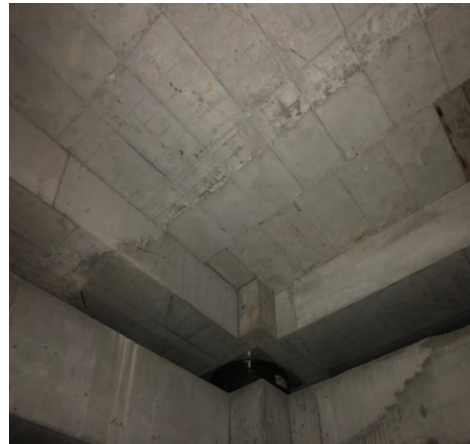
Resim 2.1 Betonarme Yapıda İmalat Sırasında Oluşan Soğuk Derzler.
