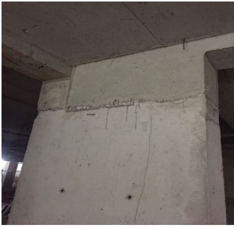
Resim 2.1 Betonarme Yapıda İmalat Sırasında Oluşan Soğuk Derzler.
