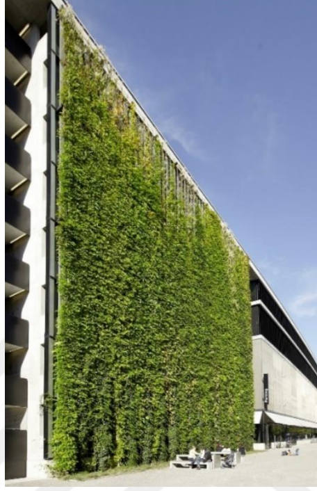
Şekil 3.5.2. Gürültü Bariyeri Uygulaması (url 36)
