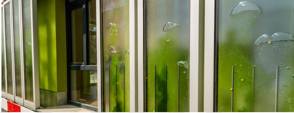
Şekil 5.12.2. Biyoreaktör Evi Cephe Paneli Detayı (url 58)
