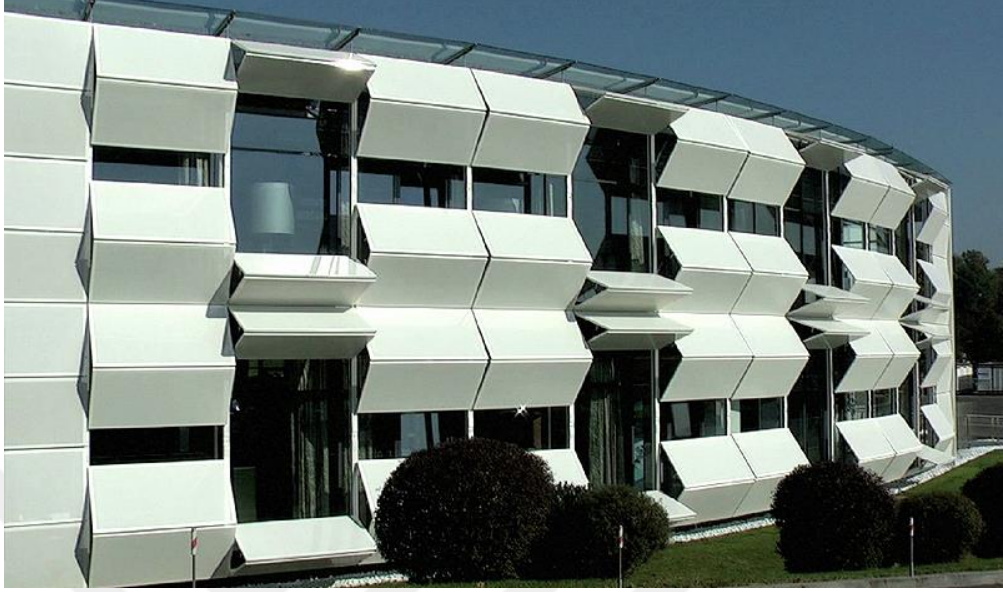
Şekil 5.8.1. Kiefer Teknik Showroom Cephe Görüntüsü (url 55)
