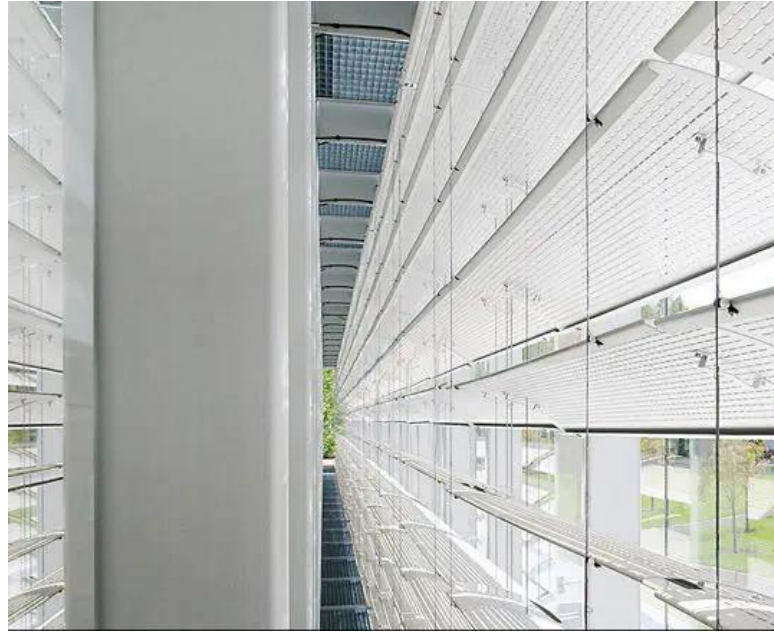
Şekil 3.5.3. Cambridge Kütüphanesi Çift Cidarlı Cephe Örneği (url 37)
