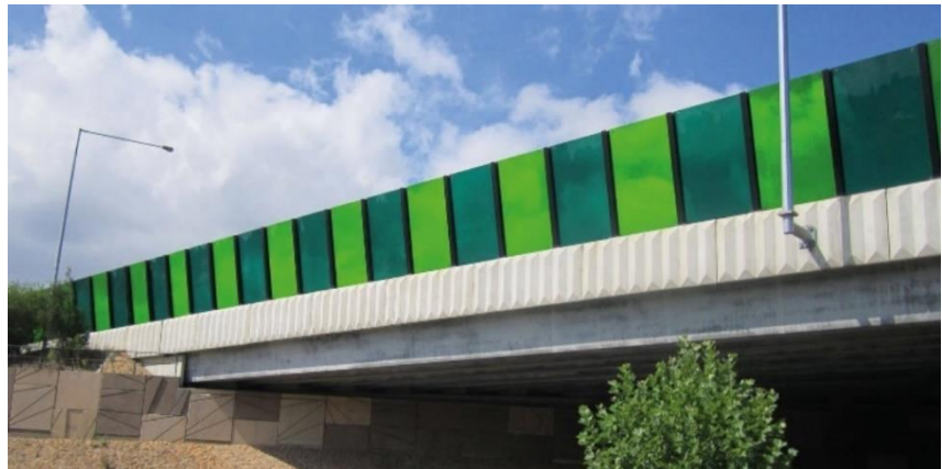
Şekil 3.5.1. Gürültü Bariyeri Uygulaması (url 35)
