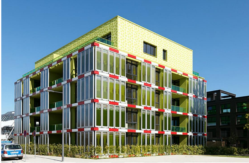
Şekil 5.12.1. Biyoreaktör Evi Cephe Görünüşü (url 58)
