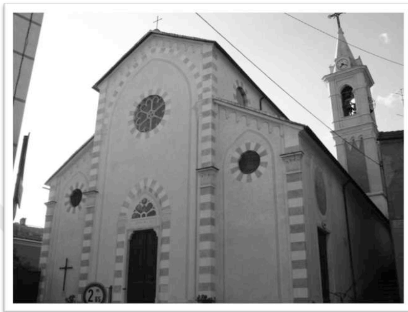
Figura 47 - La chiesa di San Rocco, stato attuale (dopo il recente restauro)
