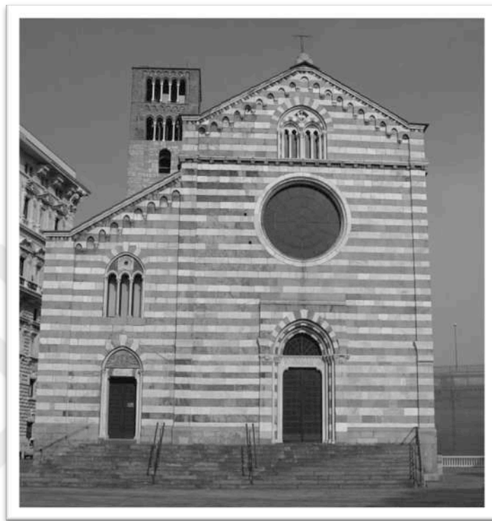
Figura 61 – La chiesa di Santo Stefano, stato attuale
