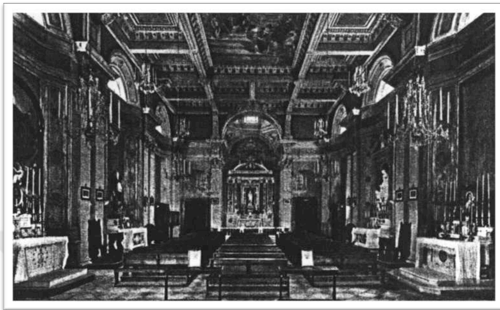
Figura 170 – L'interno della chiesa dopo l'intervento di Basso, A.P.S.P.
