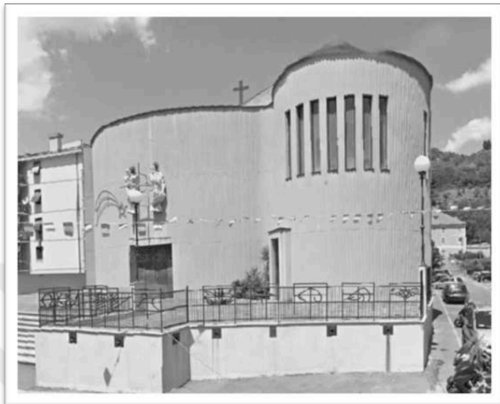
Figura 138 - Chiesa dei SS. Cosma e Damiano, stato attuale
