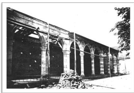
Figura 116 – Il portico durante la costruzione, A.S.S.P.
