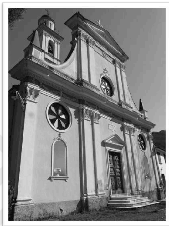
Figura 11 - La facciata della chiesa di Sant'Ambrogio, stato attuale
