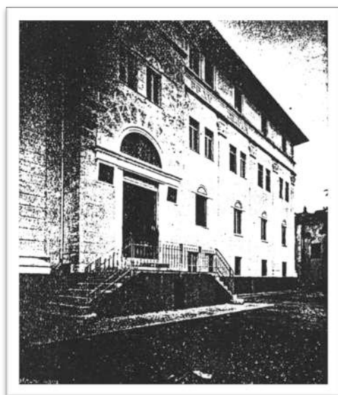
Figura 153 – La facciata principale, foto d'epoca
