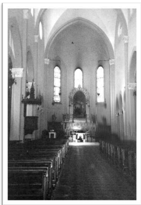
Figura 80 – Vista interna della chiesa, stato attuale
