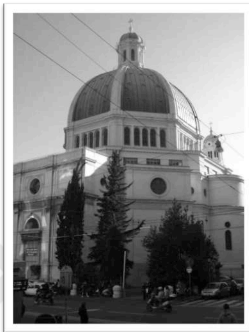
Figura 123 – La chiesa di Santa Zita, stato attuale
