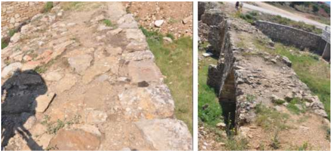
Şekil 4.3. Onaç köprüsünün döşeme yakın ve genel görünümü
