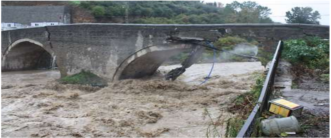
Şekil 3.16. Aşırı yağmur sonucu tamamen yıkılan Osmanbaba köprüsü (Yanık vd. 2017)
