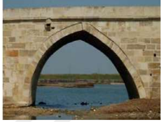
Şekil 3.17. Yanlış onarım nedeniyle deforme olmuş Büyükçekmece köprüsü (Yanık vd. 2017)
