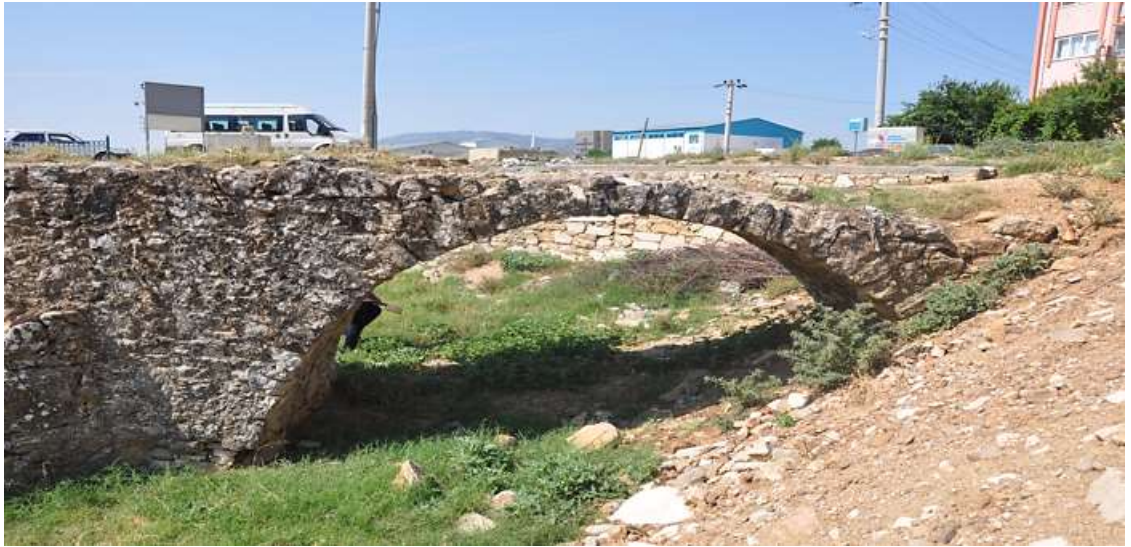
Şekil 4.8. A04 numaralı köprü ayağı
