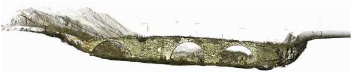
Şekil 4.13. Mansap yönü 3D Pointcloud Ortofotosu
