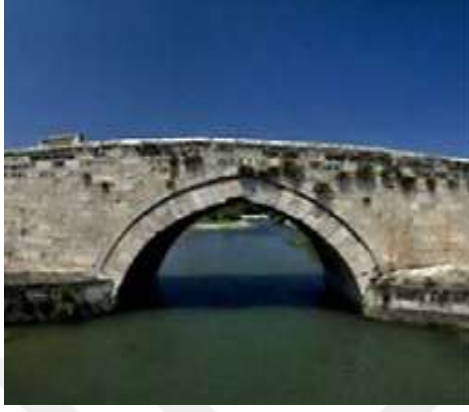
Şekil 3.17. Yanlış onarım nedeniyle deforme olmuş Büyükçekmece köprüsü (Yanık vd. 2017)
