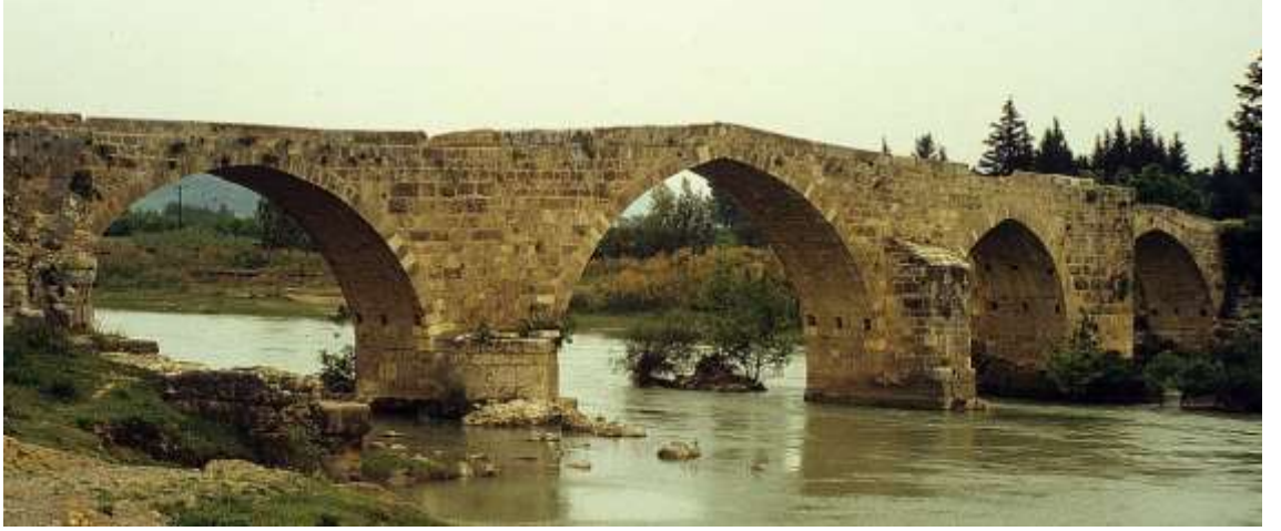
Şekil 3.1. Roma dönemine ait Aspendos (Köprüpazarı) Köprüsü (Anonim 1, 2022)
