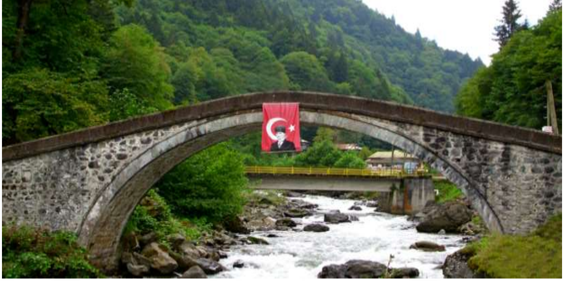
Şekil 3.7. Dik kemerli Şenyuva Köprüsü (Anonim 7, 2014)
