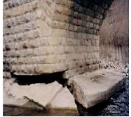
Şekil 3.18. Zemin kaynaklı hasara uğramış Mataracı köprüsü (Yanık vd. 2017)
