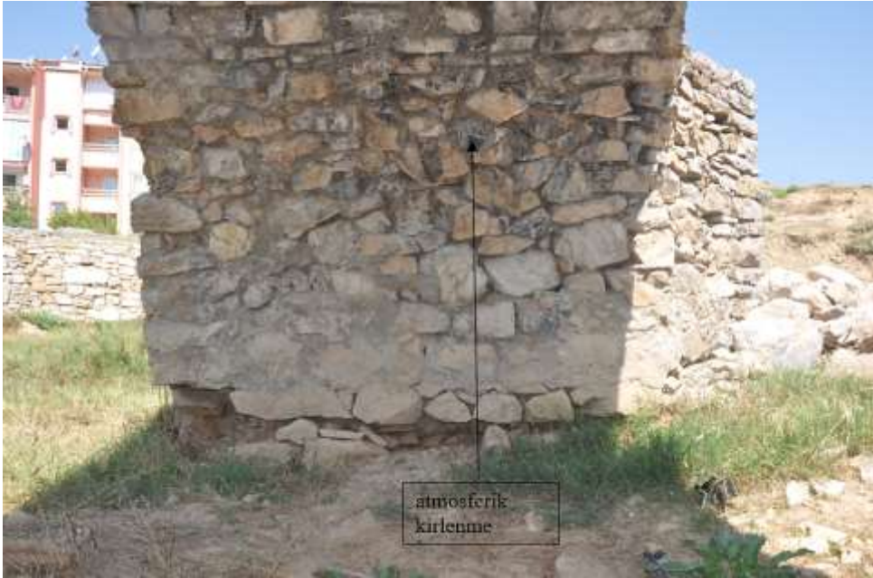
Şekil 4.10. Mansap yönü K01 numaralı kemer iç yüzeyindeki atmosferik kirlenme
