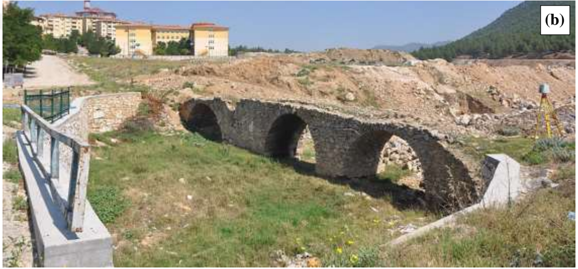
Şekil 4.2. Onaç köprüsünün a) memba; b) mansap yönünden görünümü
