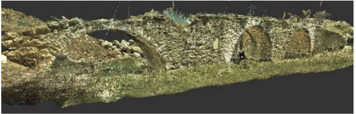
Şekil 4.15. Yersel lazer tarama ile oluşturulan mansap yönü nokta bulutu
