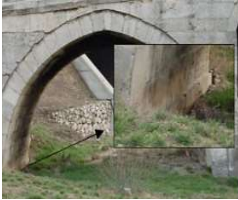
Şekil 3.18. Zemin kaynaklı hasara uğramış Mataracı köprüsü (Yanık vd. 2017)
