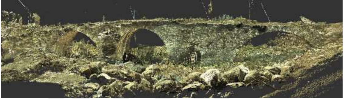
Şekil 4.14. Yersel lazer tarama ile oluşturulan memba yönü nokta bulutu
