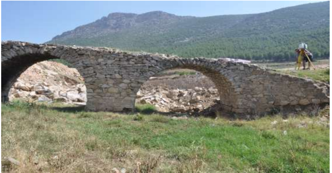
Şekil 3.21. Yapıda yersel lazer tarayıcının konumlandırılması
