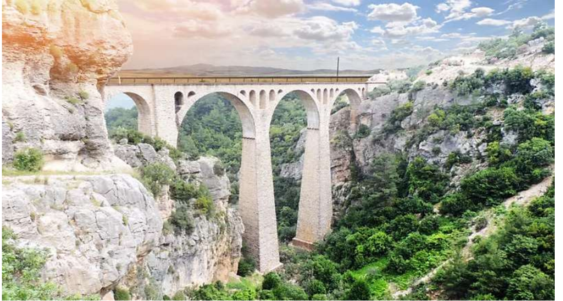
Şekil 3.12. Yüksek sütunlu kemer köprü örneği Varda köprüsü (Anonim 10, 2022)
