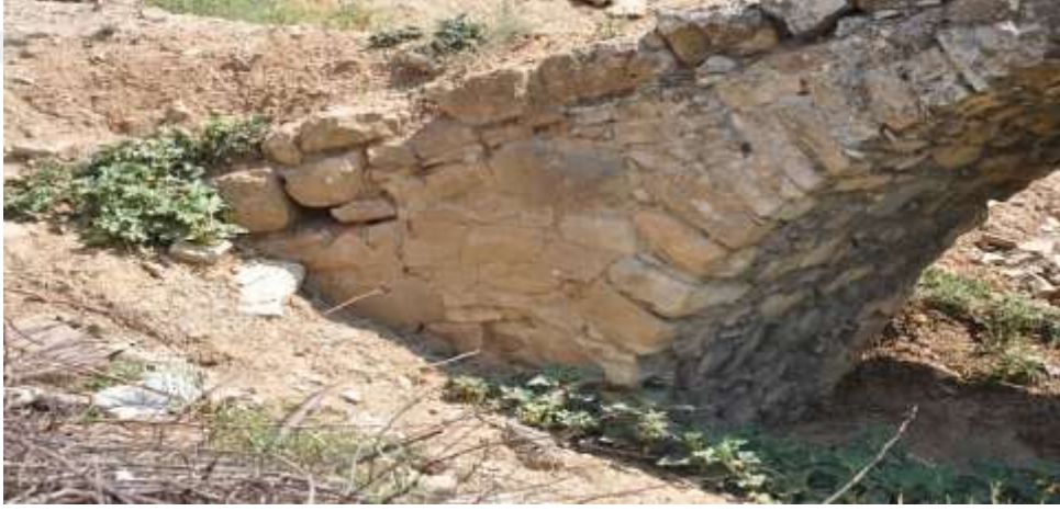
Şekil 4.9. Mansap yönü A04 numaralı ayakta malzeme boşalması
