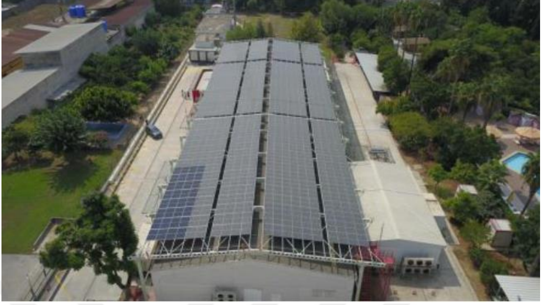
Şekil 2.32. Vodafone Adana Teknoloji Merkezi
