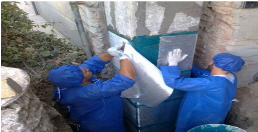
Şekil 2. Cam takviyeli polimer ile güçlendirme
