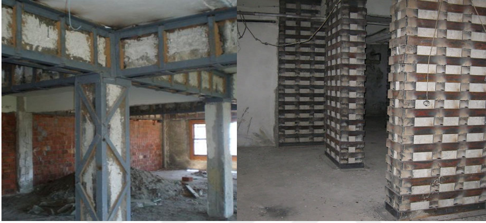
Şekil 3. Çelik levha ile güçlendirme
