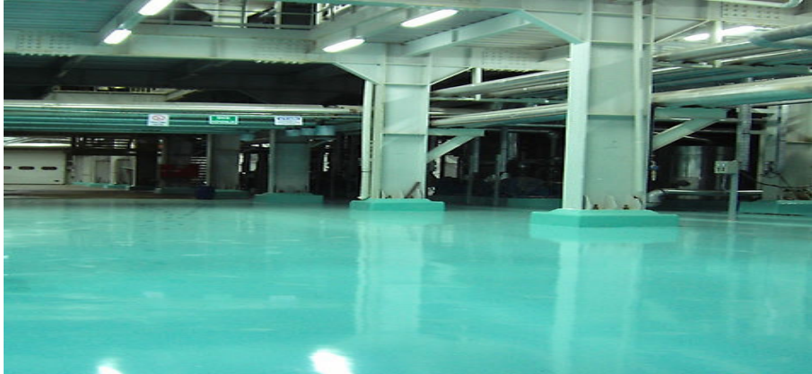
Şekil 7. Epoksi zemin kaplama ile güçlendirme
