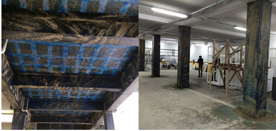
Şekil 1. Karbon lif takviyeli polimer ile güçlendirme
