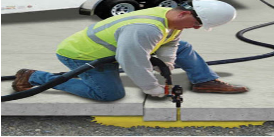
Şekil 6. Poliüretan enjeksiyon ile güçlendirme
