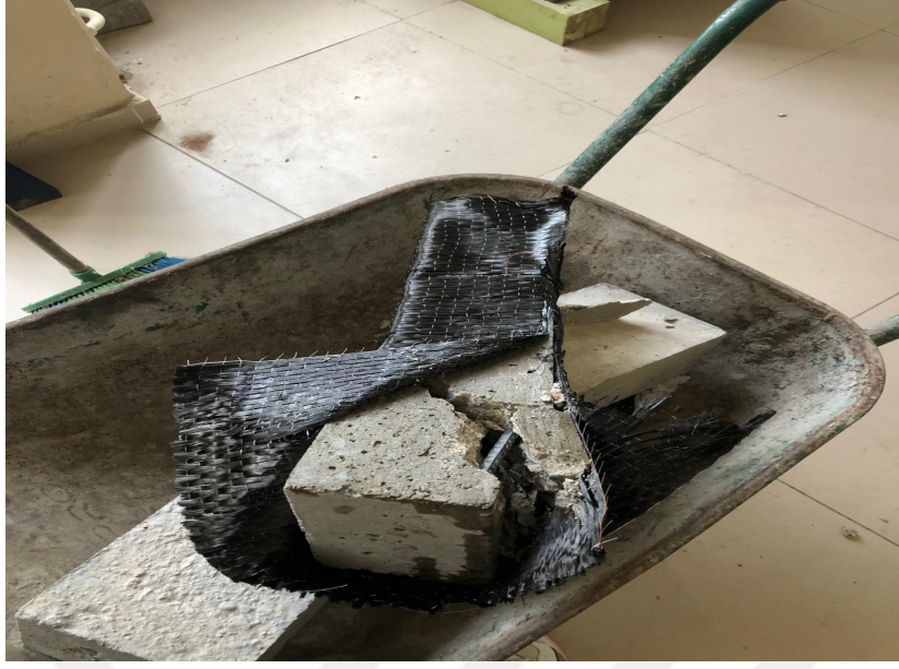
Şekil 26. Güçlendirilmiş 24 °C kiriş numunesinin yükleme sonrası hali
