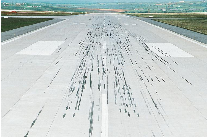
Görsel 7.11. Pist üzerindeki lastik izleri (Kamat, 2022)
