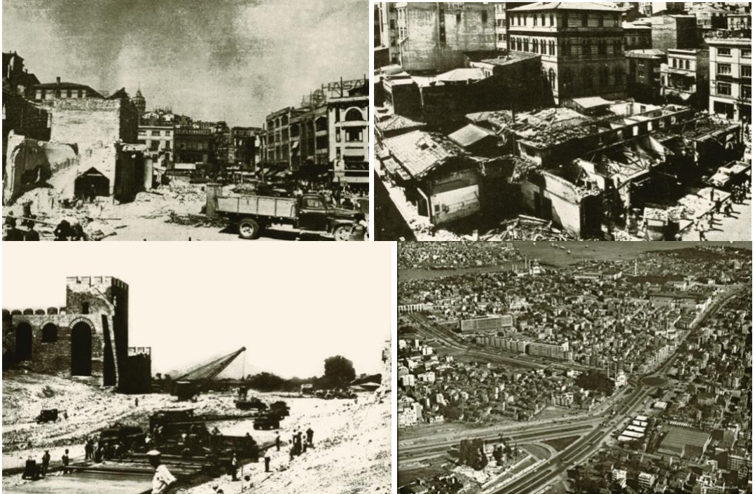
Şekil 4.6 : İstimplaklar sırasında İstanbul. Karaköy Meydanı (yukarıda), Millet caddesi yol genişletme çalışması (aşağıda, solda), Vatan ve Millet caddeleri hava fotoğrafı (aşağıda, sağda), (Url-30).
