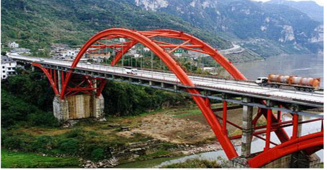
Şekil 3.2. Çin’de bulunan 121 m açıklığa sahip Liantou köprüsü (Anonymous 2022)
