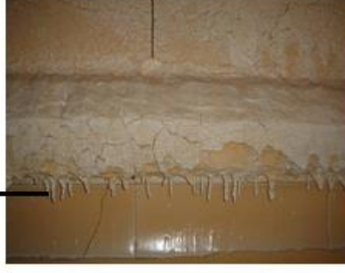
Şekil 3.19 Üst yapının akıntı ile sarkıt oluşurması [42]
