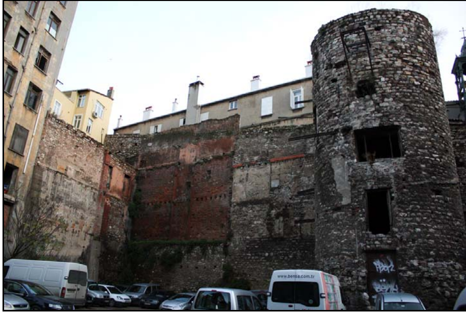
Şekil 3.34 : Bereketzade Mahallesi 162 adada bulunan sur duvarları ve güney burcunun Şair Ziya Paşa Caddesi yönü cephesi (Okur, E., 2011)
