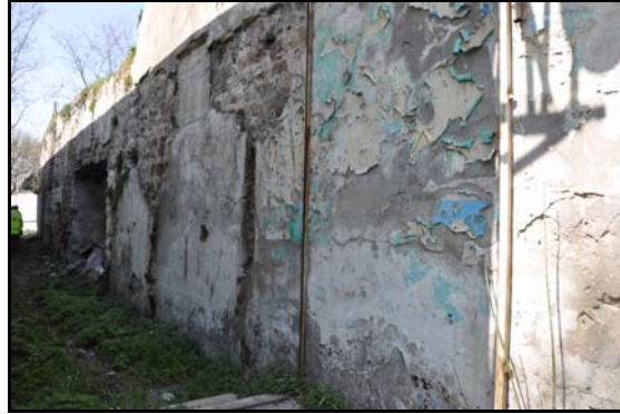
Şekil 3.21 : Tersane Caddesi üzerinde 1488 ada 86, 83, 102, 17, 18, 19, 20, 21, 22 parsellerin yıkılması ile çıkan duvarın güney cephesi (İstanbul II Numaralı Kültür ve Tabiat Varlıklarını Koruma Kurulu, 2010)
