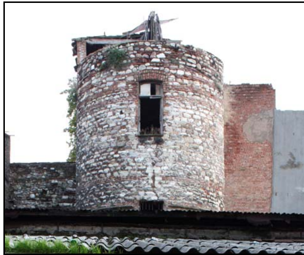
Şekil 3.35 : Bereketzade Mahallesi 162 adada bulunan sur duvarları ve kuzey burcunun Laleli Çeşme Sokak yönü cephesi (Okur, E., 2011)
