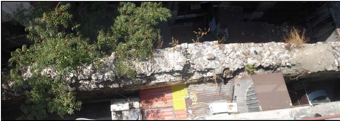
Şekil 3.11 : Yanık Kapı Sokak 253 adada yer alan sur duvarı (Bimtaş, 2009)
