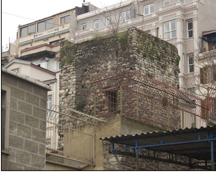
Şekil 3.42 : Müeyyadzade Mahallesi 115 adada bulunan kulenin doğu ve kuzey cephesi (Okur, E., 2011)
