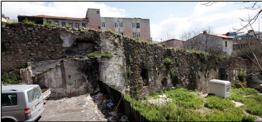
Şekil 3.7 : Yolcuzade Sokak 270 adada yer alan sur parçalarının batı cephesi (Coşkunçay, M., 2011)
