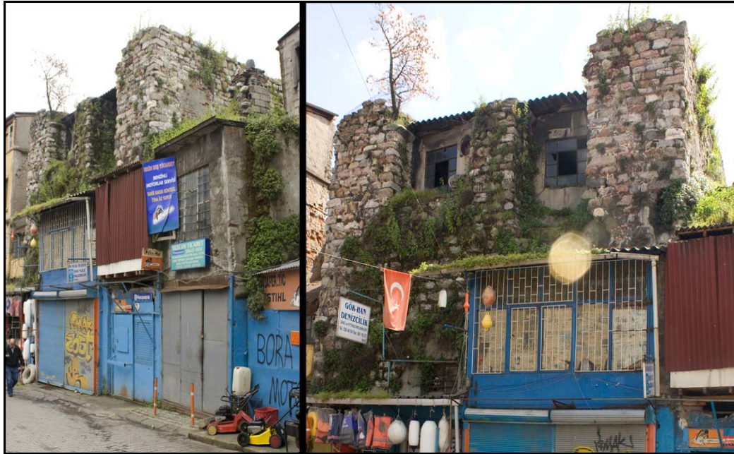
Şekil 3.27 : Yeniciler Caddesi 1506 ada 14 parseldeki kulenin kuzey cephesi (Okur, E., 2011)
