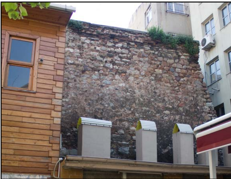
Şekil 3.50 : Kemankeş Caddesi'nde 94 ada 9 parselde bulunan eski Galata Mahzeni olan Yeraltı Camii kuzeydoğu duvarı (Okur, E., 2011)
