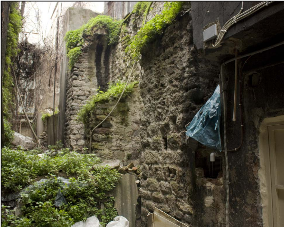
Şekil 3.29 : Arap Camii Mahallesi Fermeñeciler Caddesi 1122 adada 9, 10, 11 ve 93 parsellerde bulunan kemerli sur duvarlarının kuzey cephesi - Rüstempaşa Hanı'ndan bakış (Okur, E., 2011)
