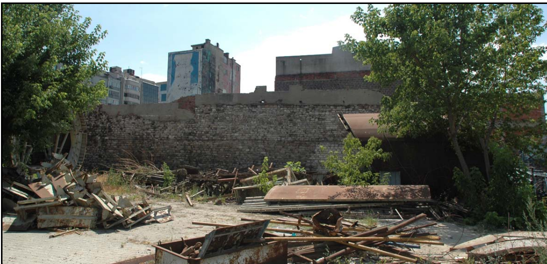
Şekil 3.18 : Tersane Caddesi üzerinde 1488 ada 25, 67, 66, 56, 100 parsellerin yıkılması sonucu Harup Kapı aksının devamında kemerli duvar hattının batı cephesi (Bimtaş, 2009)
