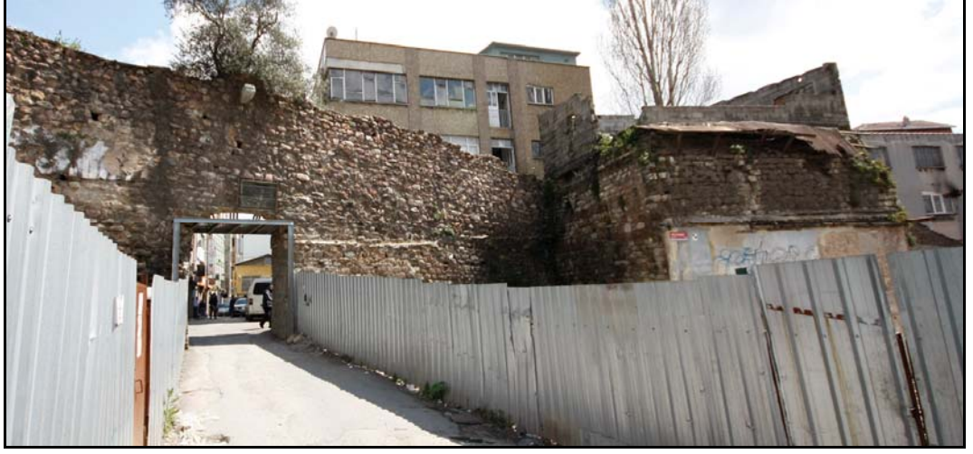
Şekil 3.8 : Yanık Kapı Sokak'ta yer alan Harup Kapı ve Yolcuzade Sokak 253 adada yer alan kule (Coşkunçay, M., 2011)
