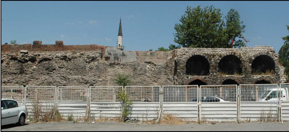
Şekil 3.17 : Tersane Caddesi üzerinde 1488 ada 25, 67, 66, 56, 100 parsellerin yıkılması sonucu Harup Kapı aksının devamında kemerli duvar hattının doğu cephesi (Bimtaş, 2009)
