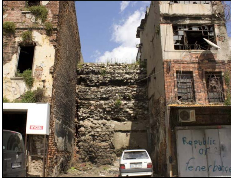
Şekil 3.26 : Yeniciler Caddesi 1508 ada 33, 34, 35 parseldeki duvar hattı güney cephesi (Okur, E., 2011)
