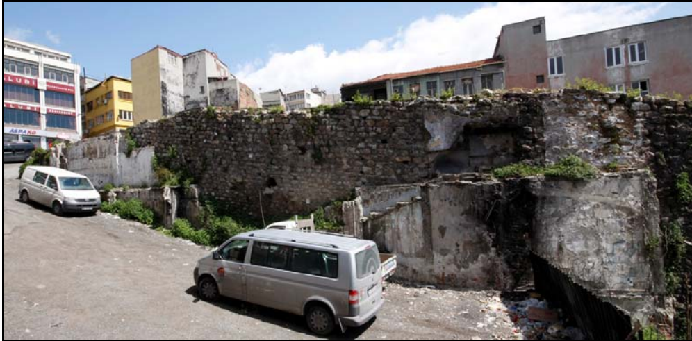
Şekil 3.6 : Yolcuzade Sokak 270 adada yer alan sur parçalarının batı cephesi (Coşkunçay, M., 2011)
