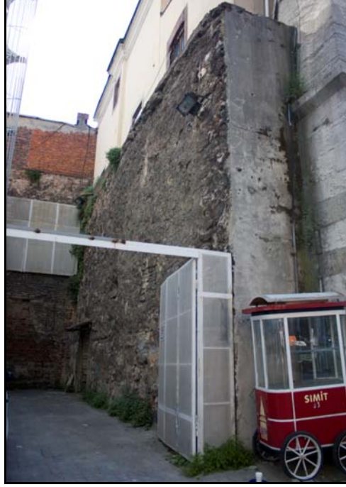
Şekil 3.51 : Kemankeş Caddesi'nde 94 ada 100, 101, 102, 132, 133, 141 ve 7 parselde sur duvarı (Okur, E., 2011)
