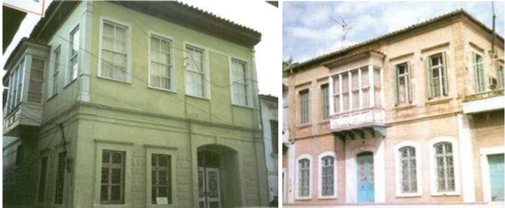
Şekil 64 Antalya Geleneksel Konutları, 19.yy. Sonu, Haşimişcan Mahallesi Pencere ve Kapılardaki Taş Söveli Örnekler (Antalya Valiliği, 2003a, s:73,75).
