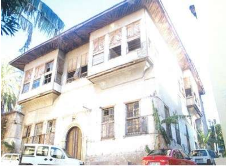
Şekil 68 Antalya Kaleiçi Ada/Parsel 115/10, Ahşap Panjur ve Kafes Örneği (Antalya Valiliği, 2003a, s:48).
