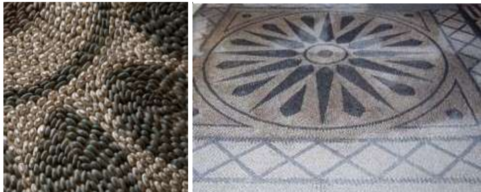
Şekil 76 Antalya Kaleiçi Geleneksel Konutlarında Taşlık Zemin Kaplama Detayları (Büket Güçbey Fotoğraf Arşivi, 2011).
