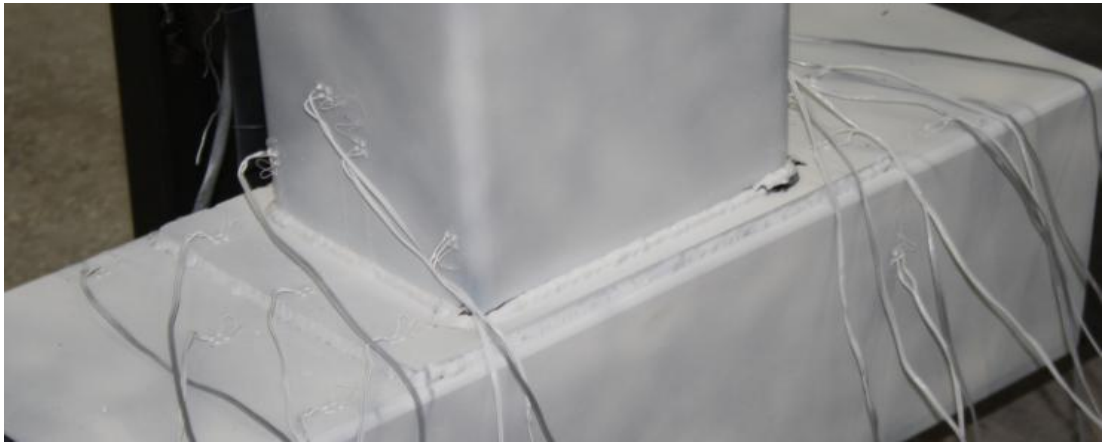
c) Çevrimsel yükleme sonrası basınç ve çekme bölgesinde oluşan kaynak yırtılması
