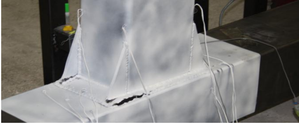
b)Yükleme sonrası genel alın levhasında ve berkitme elemanlarda kaynak yırtılması
