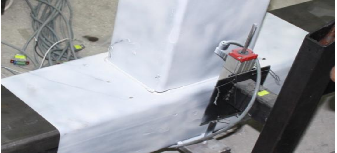
d) Yük kaldırıldıktan sonra oluşan kaynak yırtılması görünümü
