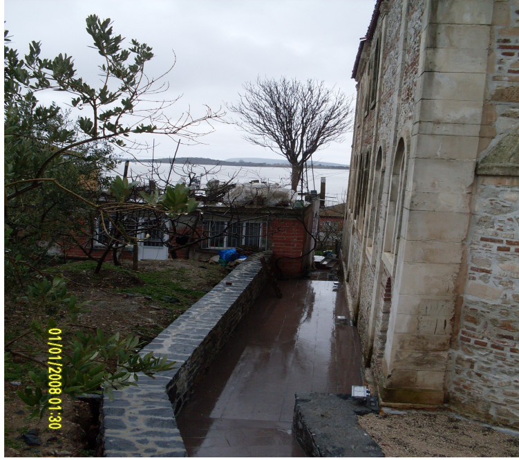
Şekil 4.15 Kilise arkasına geçiş güzergahı.
