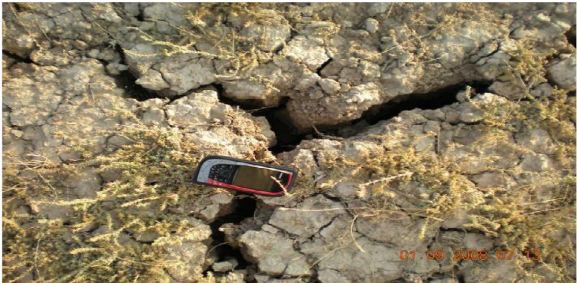
ekil 4.40. Kızılkuyu serisi toprak yüzeyinde görülen çatlaklar.
