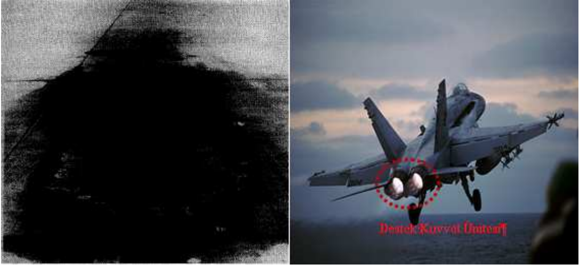
Şekil 3.1 F/A-18 uçakları park sahasındaki tipik bir hasarlı alan
