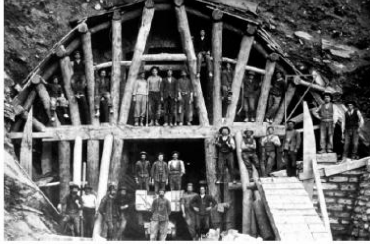
Fotoğraf 1.1. Lötchberg tüneli güney rampasındaki ahşap destek (Whittaker ve Frith, 1990)
