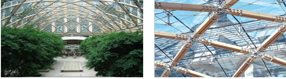
Şekil 5.19 Portcullis House, 2001 (Glulam ahşap) [74]
