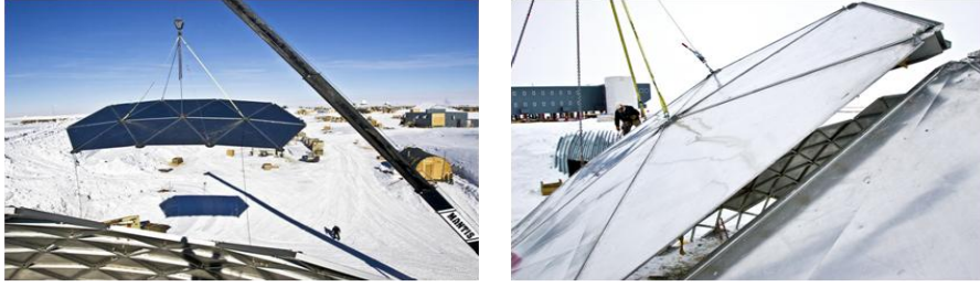
Şekil 6.18 Vinç ile kaldırma yöntemi [191]
