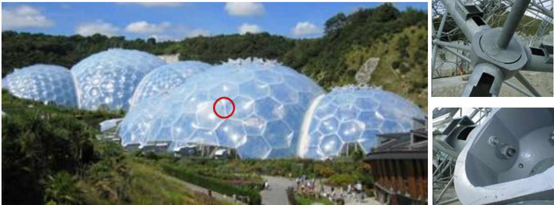
Şekil EK-1.31 Bowl birleşim detayı, Eden Projesi, İngiltere [247], [248]
