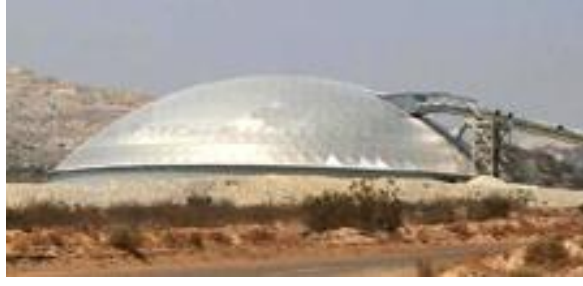
Şekil 6.5 Limestone Blending Facility yapısı [183]
