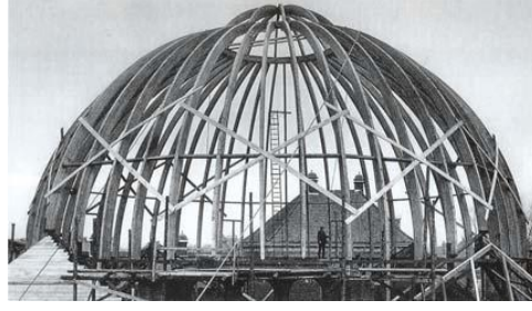
Şekil 5.21 Radial Rib Dome [82].
