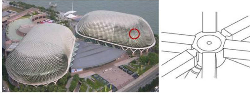
Şekil EK-1.30 Singapore Arts Center, Bowl birleşim sistemi detayı, Singapur [245], [246]
