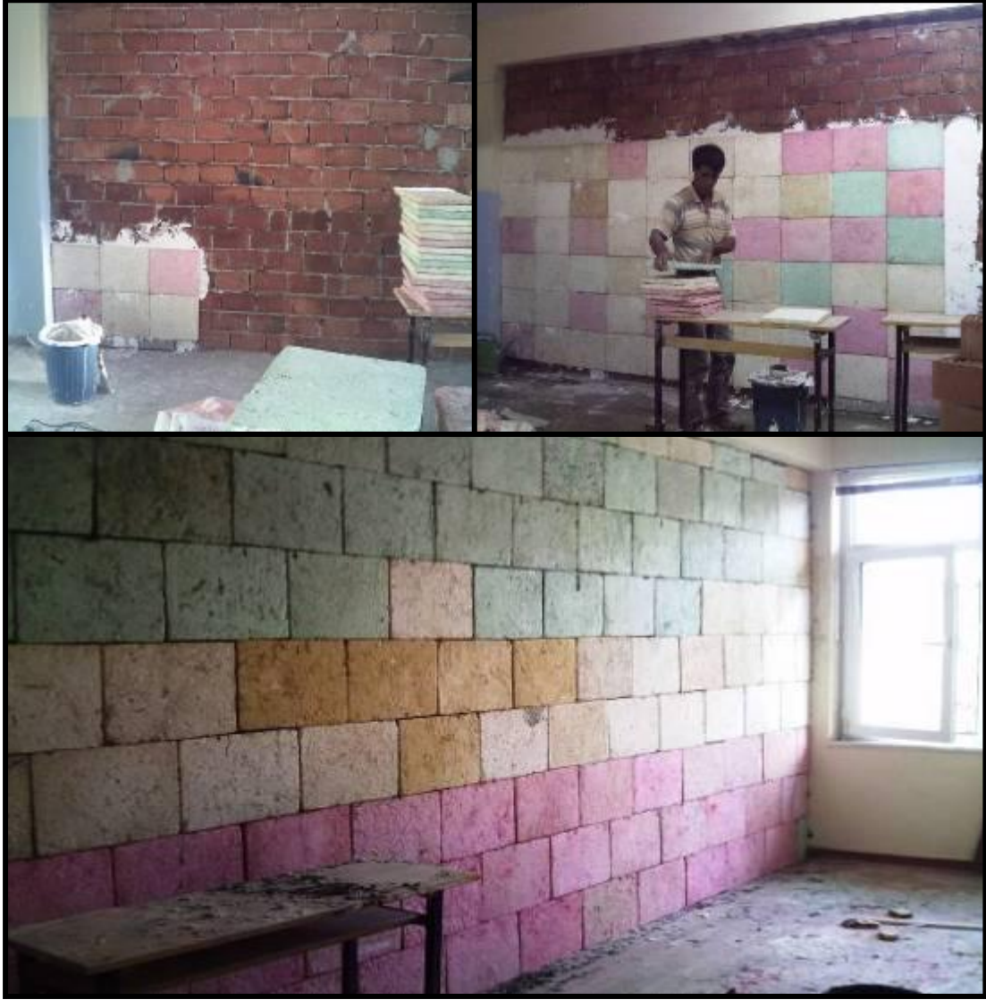
Şekil 3.12. Yalıtım malzemesinin tuğla duvara uygulanması
