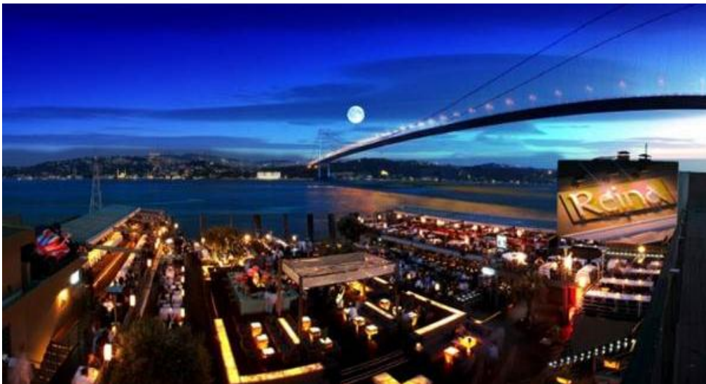
Şekil 4.19: Reina işletmesi iç mekan ve güney cephesi görünümü
