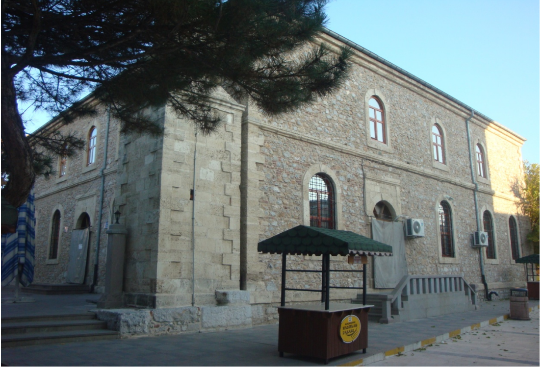
Şekil 3.16. Hamidiye cami kuzey ve batı cephesi
