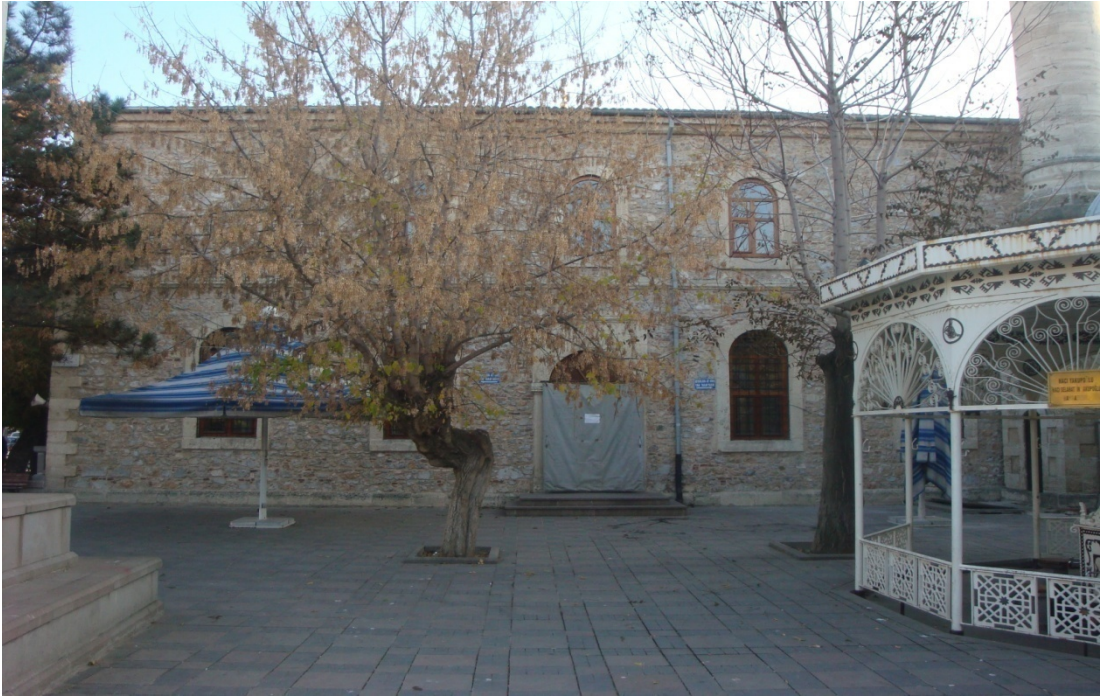
Şekil 3.17. Hamidiye cami kuzey cephesi ve şadırvan
