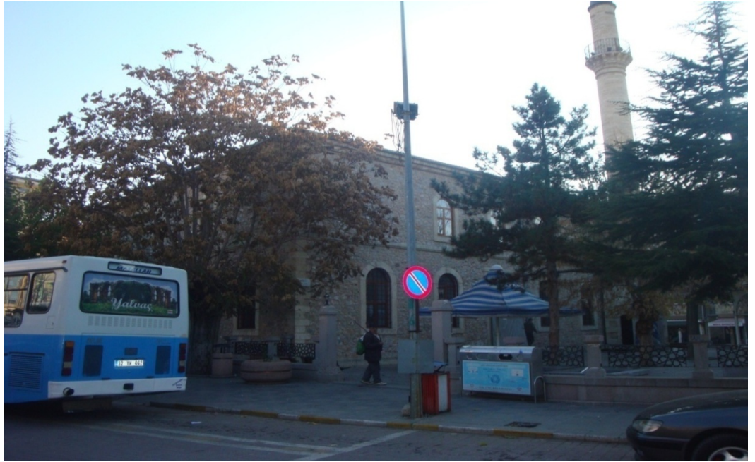
Şekil 3.15. Hamidiye cami kuzey ve doğu cephesi
