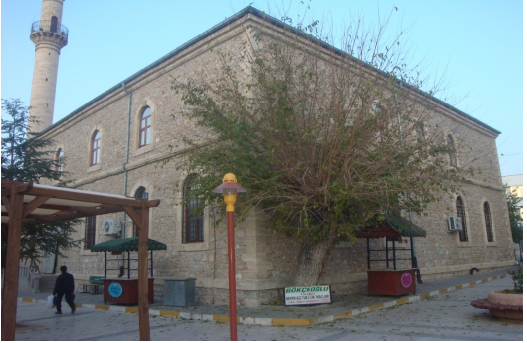
Şekil 3.14. Hamidiye cami güney ve batı cephesi
