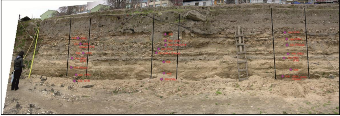
Şekil 3.4. Kazı alanının doğusundaki kesitte 5, 6 ve 7. birimlerden alınan örneklerin yerleri işaretlenmiştir (Bakış yönü: Güneyden Kuzeye).
