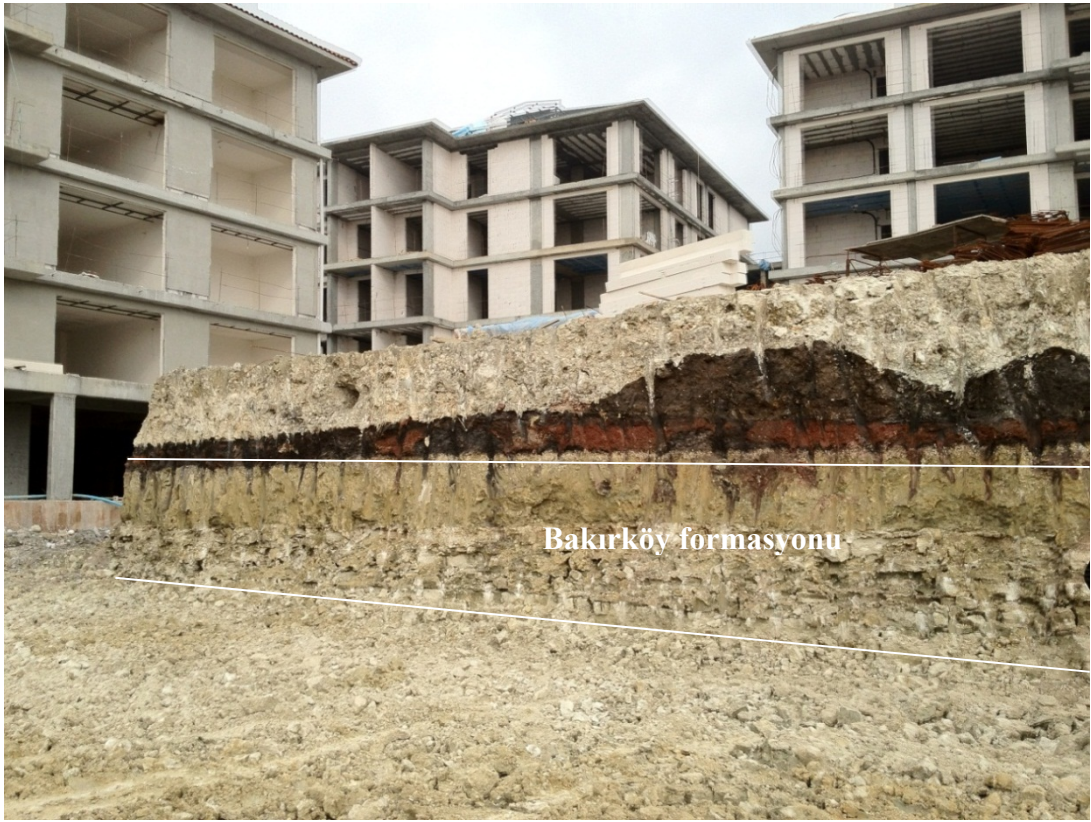
Şekil 3.5 : Avcılar Park İnşaatı temel kazısında Bakırköy formasyonu kireçtaşları.
