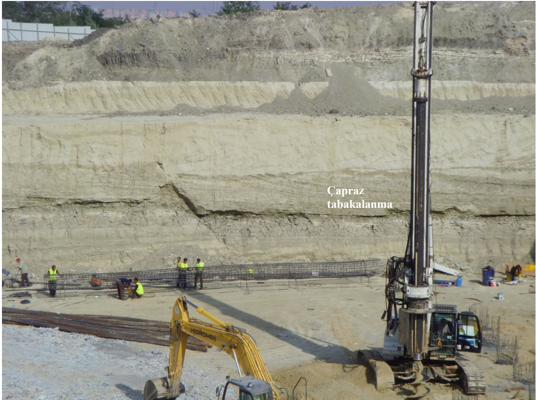
Şekil 3.3 : Esenyurt Haneplus İnşaatı temel kazısında Çukurçeşme formasyonu.
