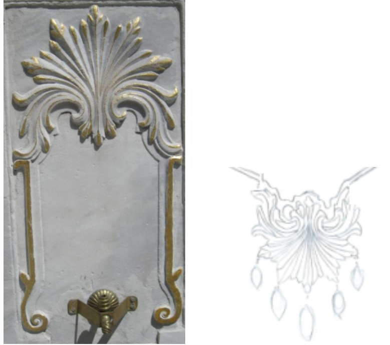
Şekil 109. Mesih Mehmet Paşa Çeşmesi Ayna Taşı Detayı ve Eskiz Çalışması
