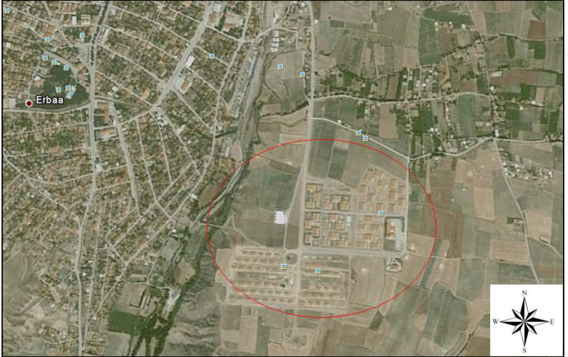
Şekil 30. Erbaa Belediyesi'nin yapmış olduğu Tepeshir Konutları Kaynak: google.earth.com
