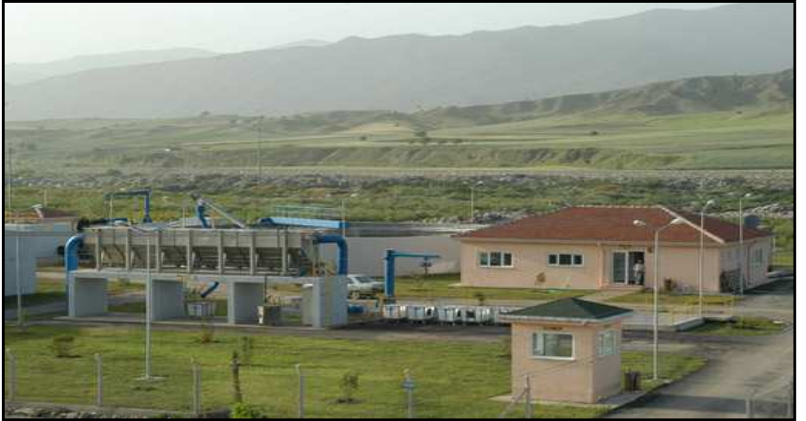
Fotoğraf 12. Atık su arıtma tesisi
