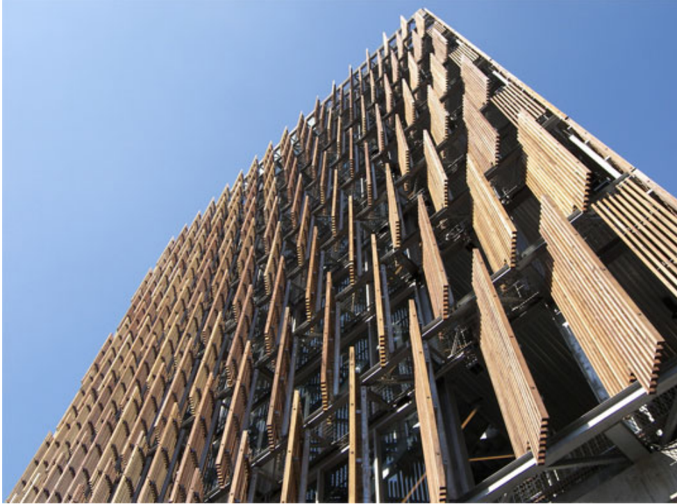
Şekil 4.11b : CH2 Binası Cephe Detayı, (Url-14).
