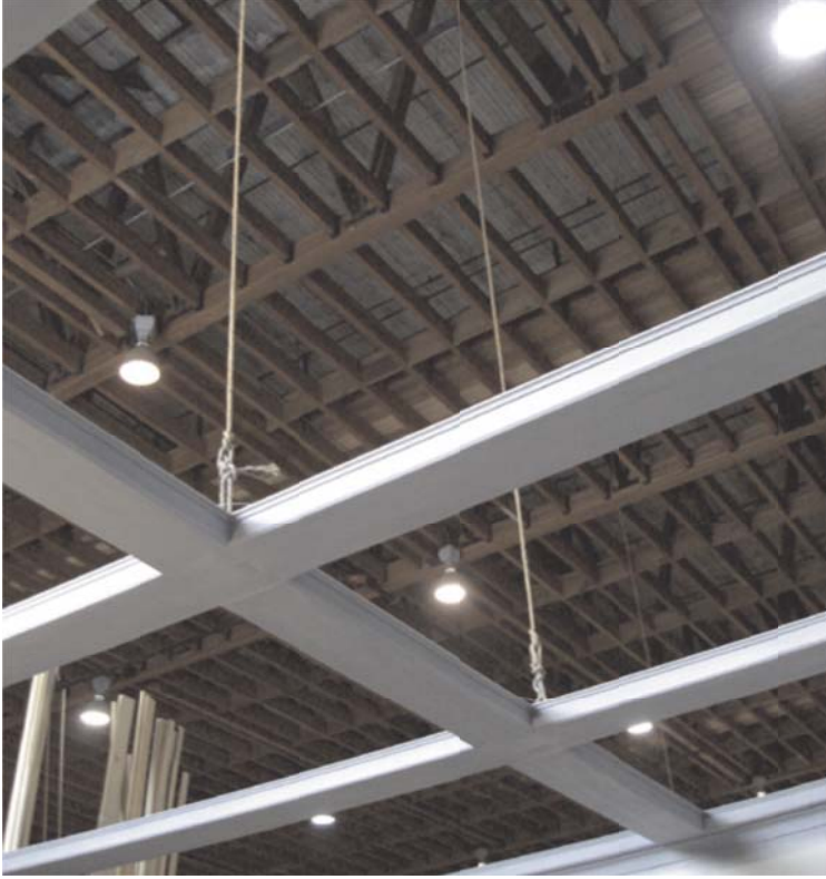
Resim 2.2. Setlerin tavandaki gridlere bağlanarak sabit hale getirilmesi [6]
