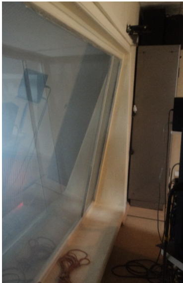
Resim 3.8. Gözlem penceresinin açılı yerleşimi
