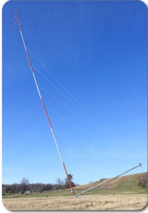
Şekil 3.12. Rüzgâr ölçüm direğinin yerden kaldırılması
