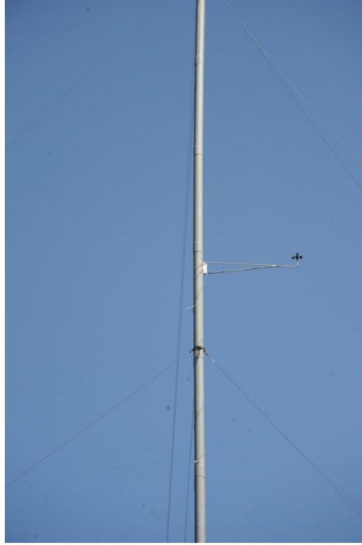
Şekil 3.18. Kampüste kurulan rüzgâr ölçüm direğinin destek halatları
