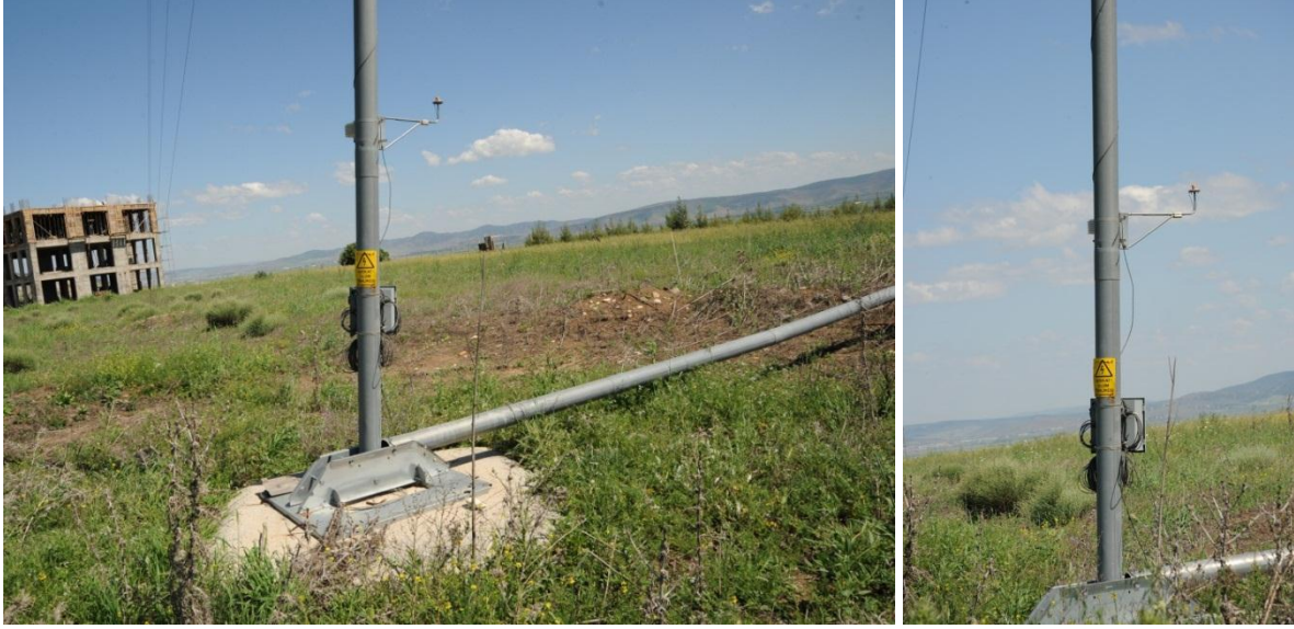
Şekil 3.14. Kampüste kurulan rüzgâr ölçüm direğinin kuruluş aşamaları
