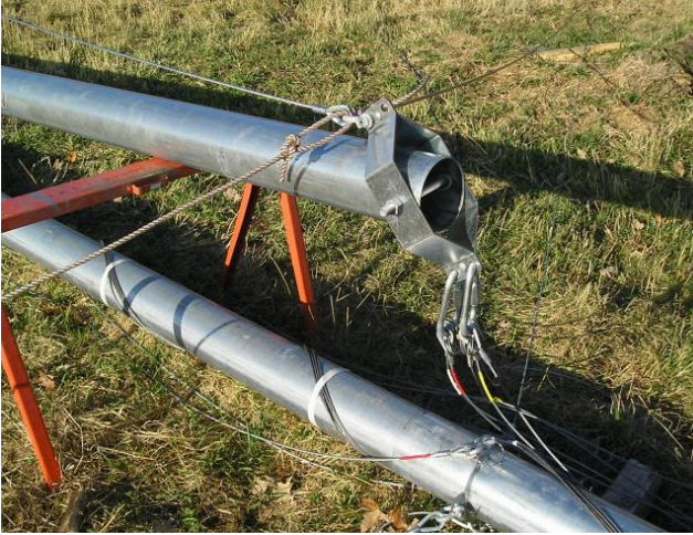
Şekil 3.11. Rüzgâr ölçüm istasyonunun kurulmadan önceki işlemler ve ölçüm direğinin ilk hali
