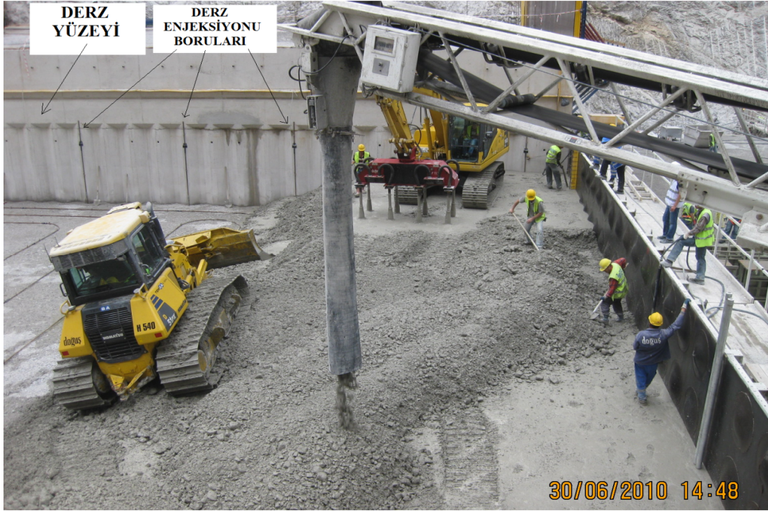
Fotoğraf 5.7. Beton yüzeyine yerleştirilen derz enjeksiyonu teçhizatı
