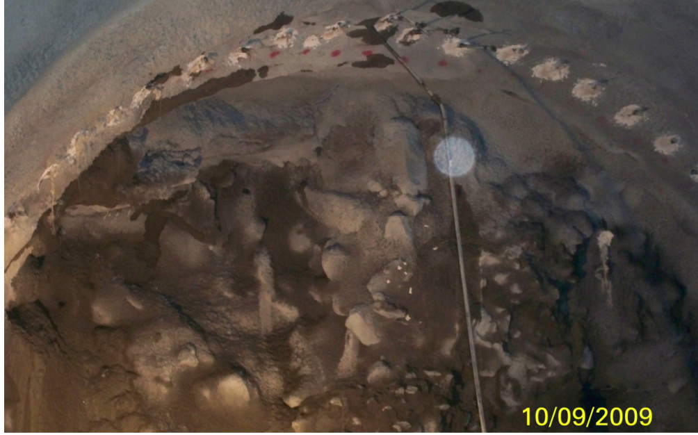
Fotoğraf 5.15. Boru süren enjeksiyonu uygulaması
