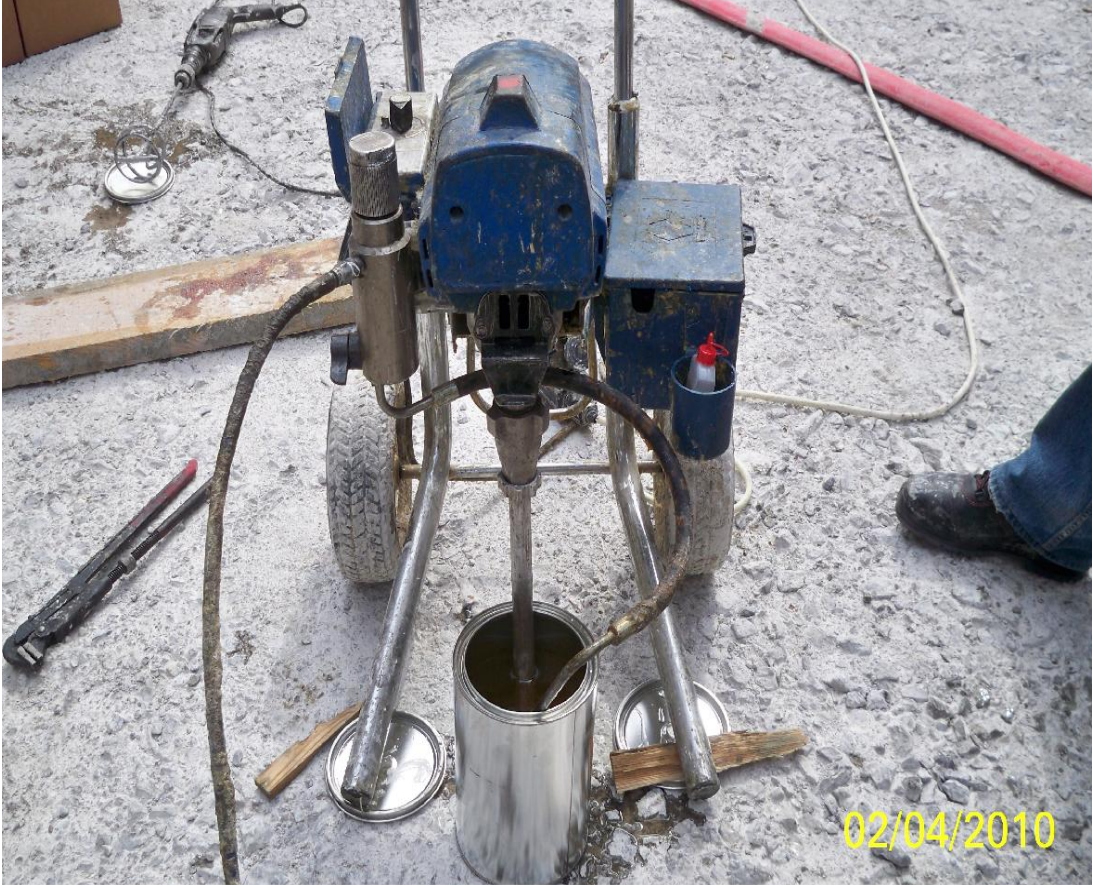
Fotoğraf 5.13. Epoksi enjeksiyonu uygulaması
