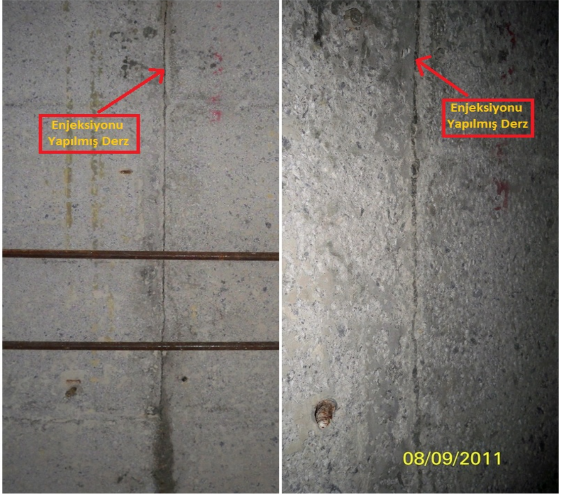
Fotoğraf 5.10. Enjeksiyon sonrasında derzlerin görünümü
