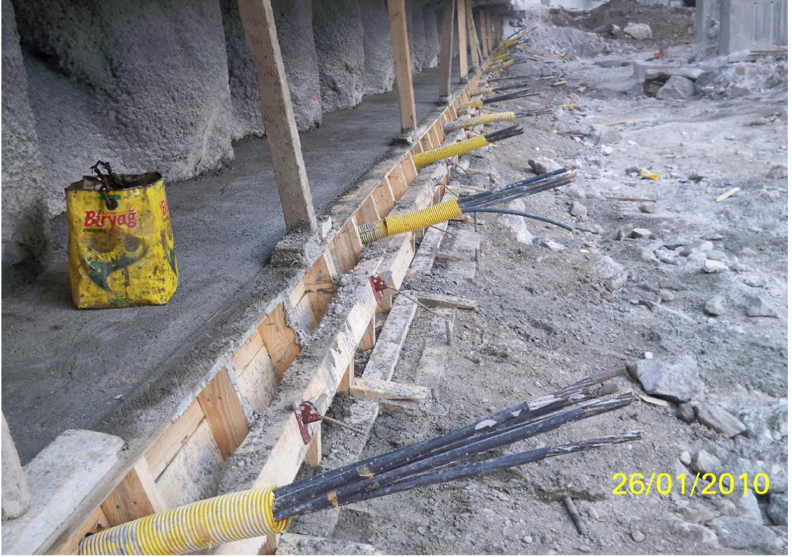
Fotoğraf 5.17. Öngermeli ankraj enjeksiyonu uygulaması
