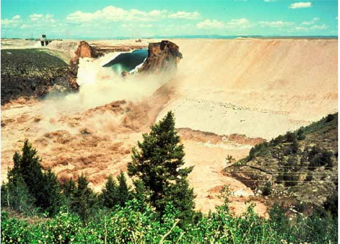
Fotoğraf 2.1. Teton Barajı'nın yıkılışı (web.mst.edu)
