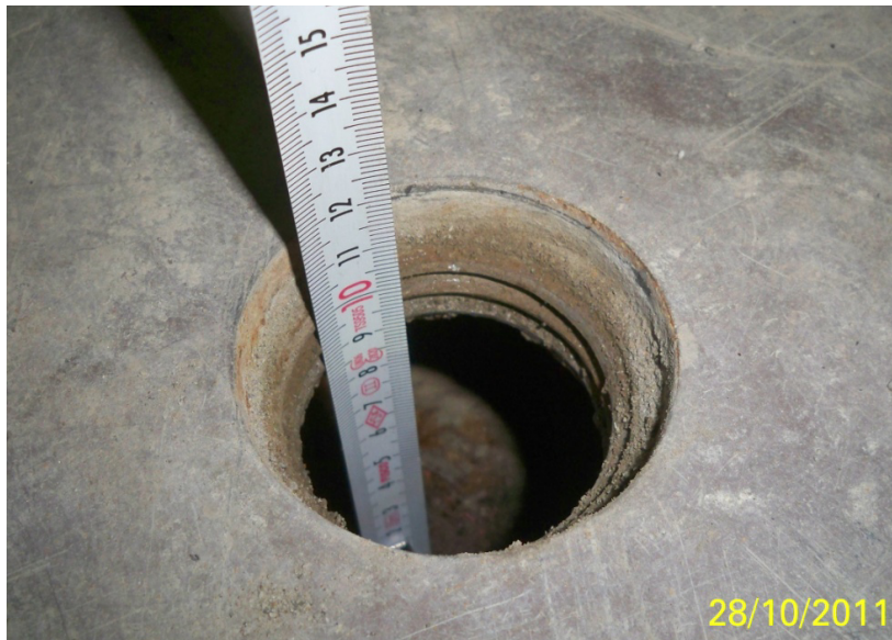
Fotoğraf 5.12. Gömülü elemanların çevresinde oluşan boşluk
