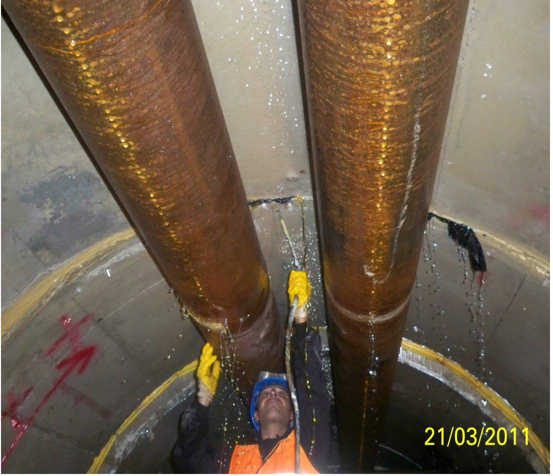
Fotoğraf 5.14. Poliüretan (köpük) enjeksiyonu uygulaması
