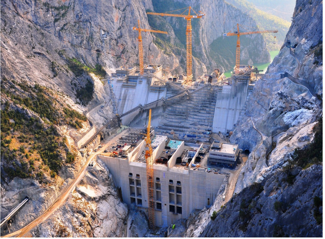
Fotoğraf 4.1. Boyabat Barajı ve HES inşaatından bir görüntü
