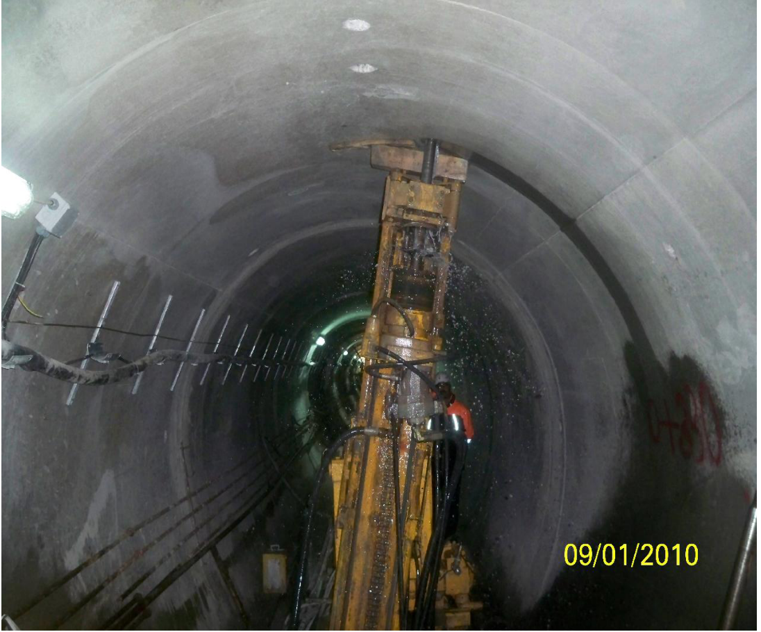
Fotoğraf 5.5. Perde bağlantı enjeksiyonu delgisi
