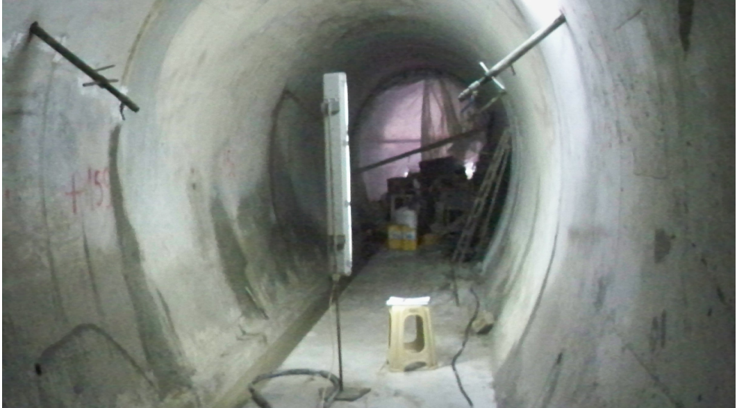
Fotoğraf 5.4. Galerideki konsolidasyon enjeksiyonundan bir kesit
