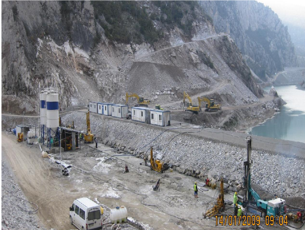
Fotoğraf 5.2. Mansap batardosu enjeksiyonu
