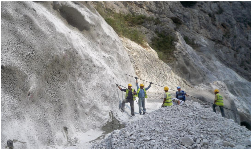
Fotoğraf 5.16. Pasif ankraj enjeksiyonu uygulaması
