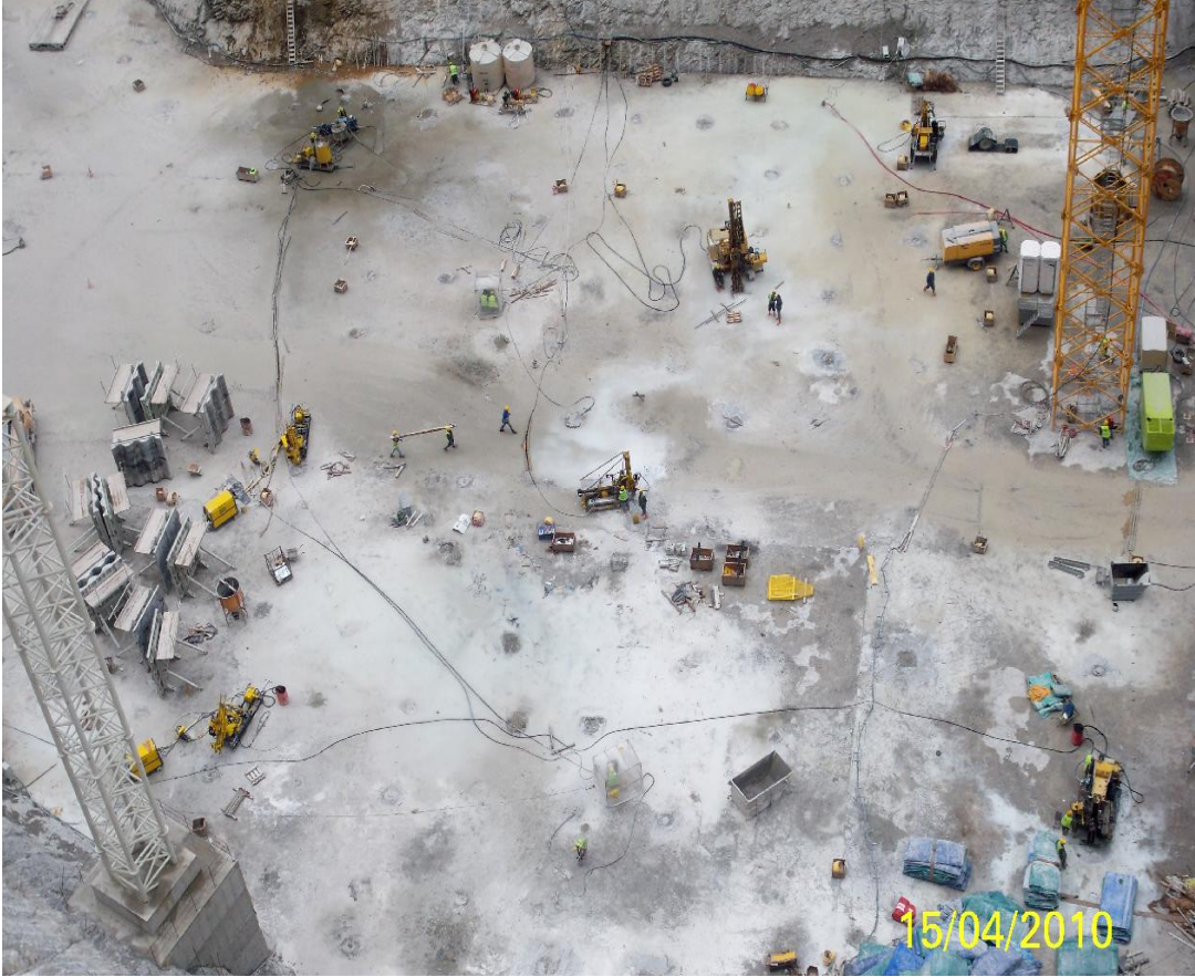
Fotoğraf 5.6. Temel konsolidasyonu çalışmalarından bir kesit
