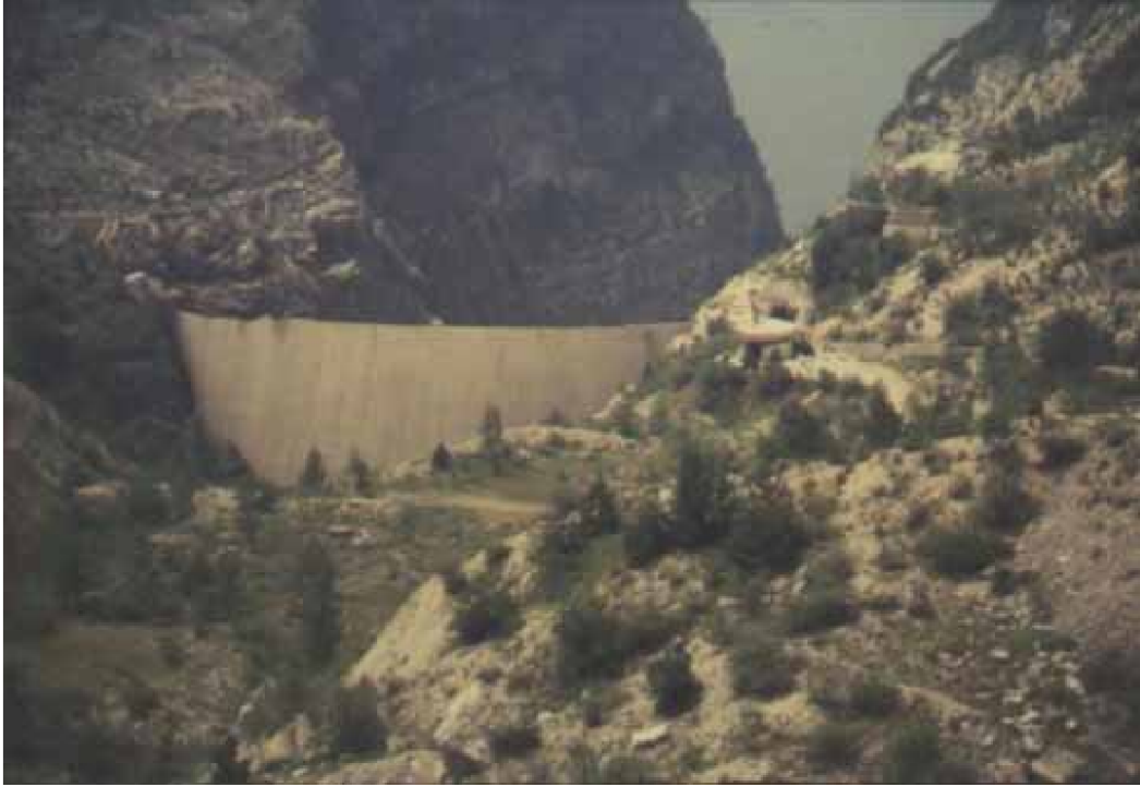
Fotoğraf 2.2. Vaiont rezervuarının heyelan malzemesiyle dolmuş hali (Ertunç, 2003)
