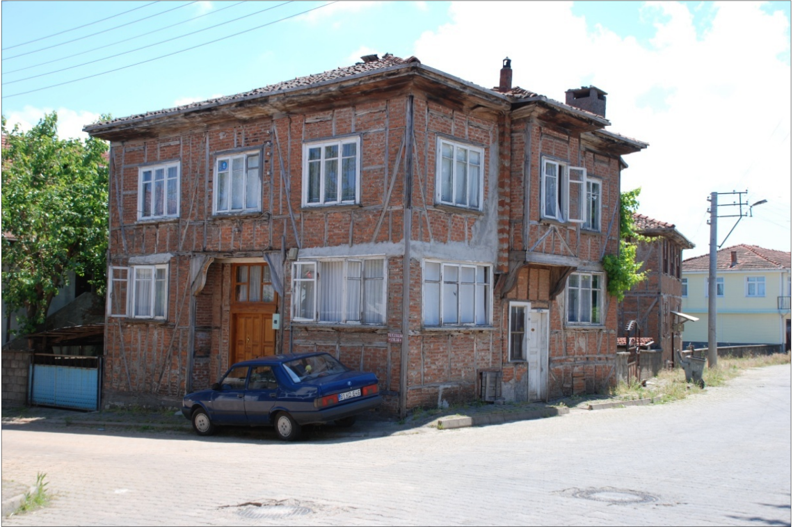
Foto 6.48. Kuzeydoğu Cepheden Görünüş (Katalog 3)
