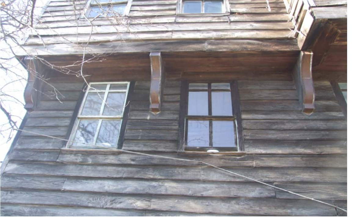
Foto 6.79. Konsollar ve Pencere Detay (Katalog 5)
