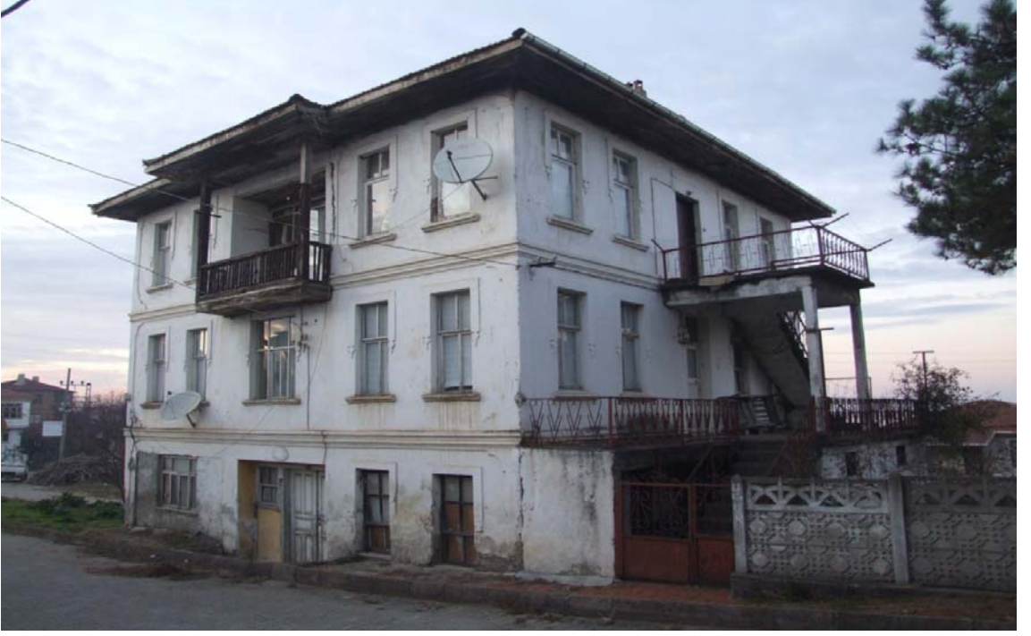
Foto 6.80. Güneydoğu Cepheden Görünüş (Katalog 6)
