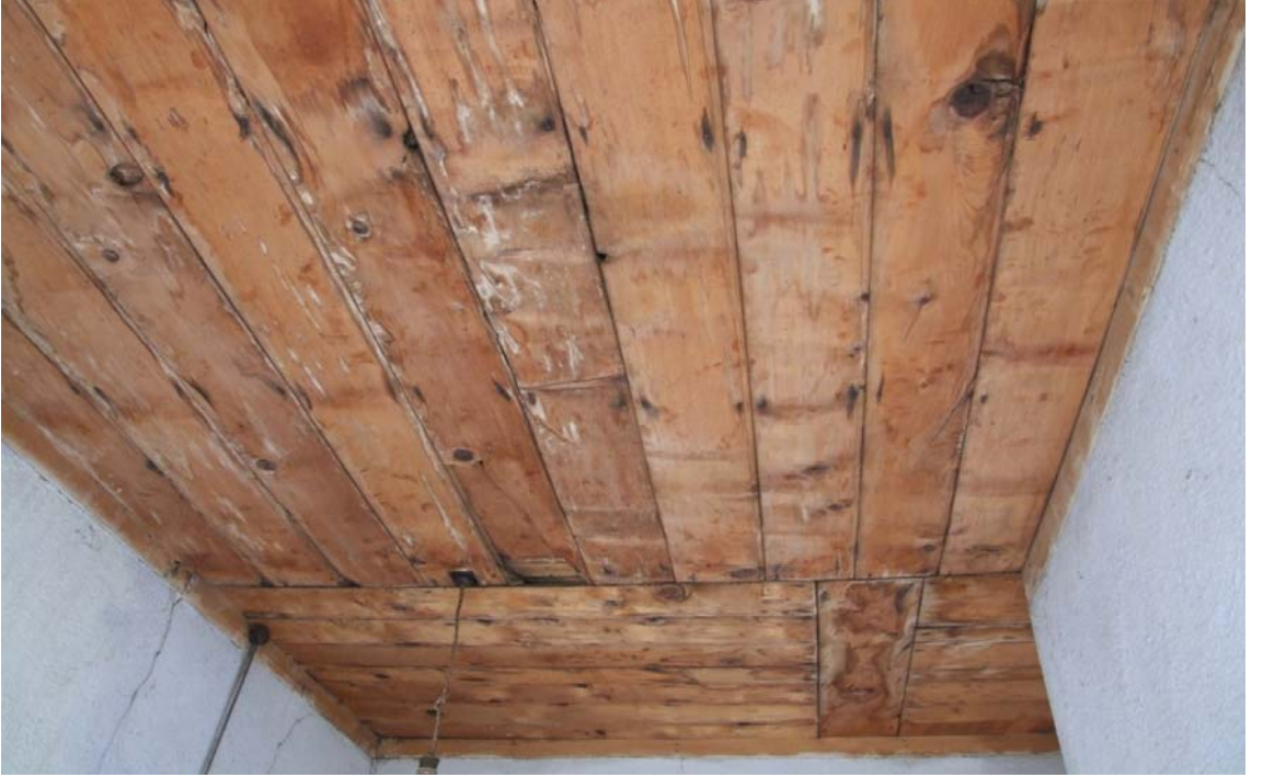
Foto 6.119. Merdivenlerin Hemen Yanındaki Odanın Tavanı (Katalog 8)
