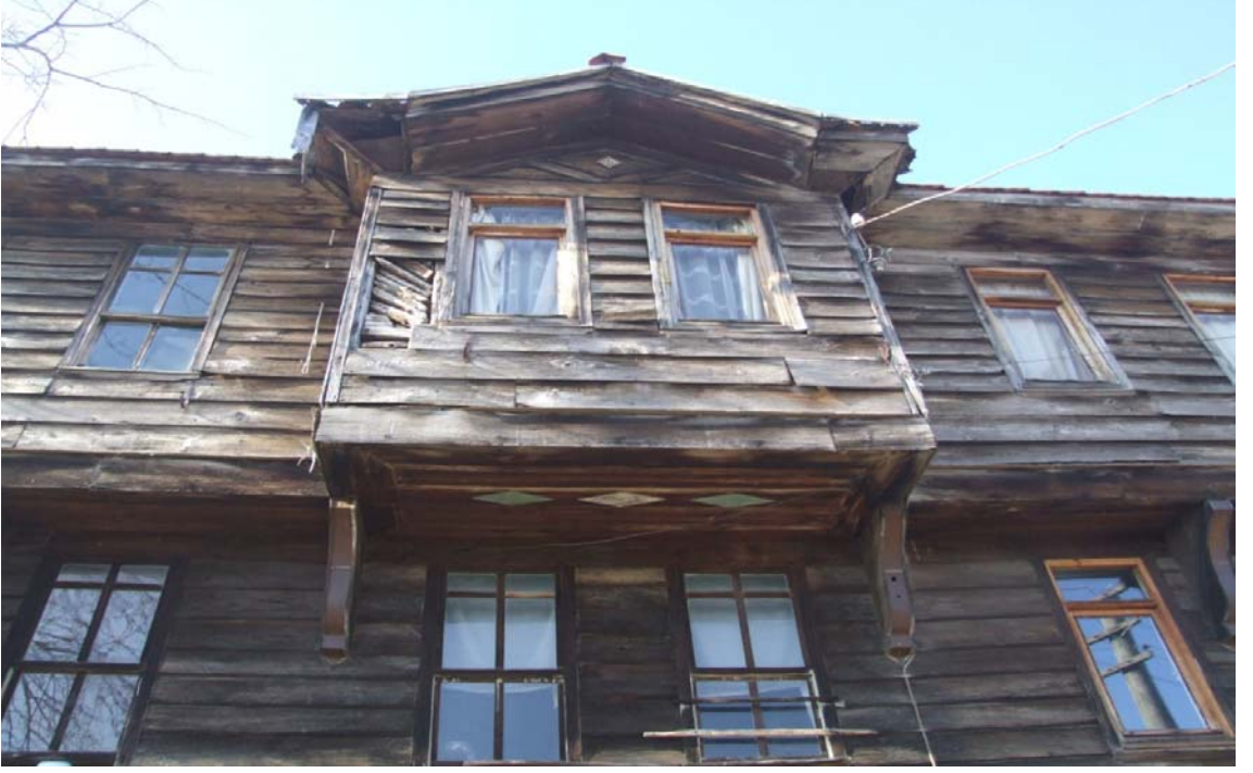
Foto 6.77. Çıkmanın Konsollarla İle Taşınması ve Üçgen Alınlık (Katalog 5)
