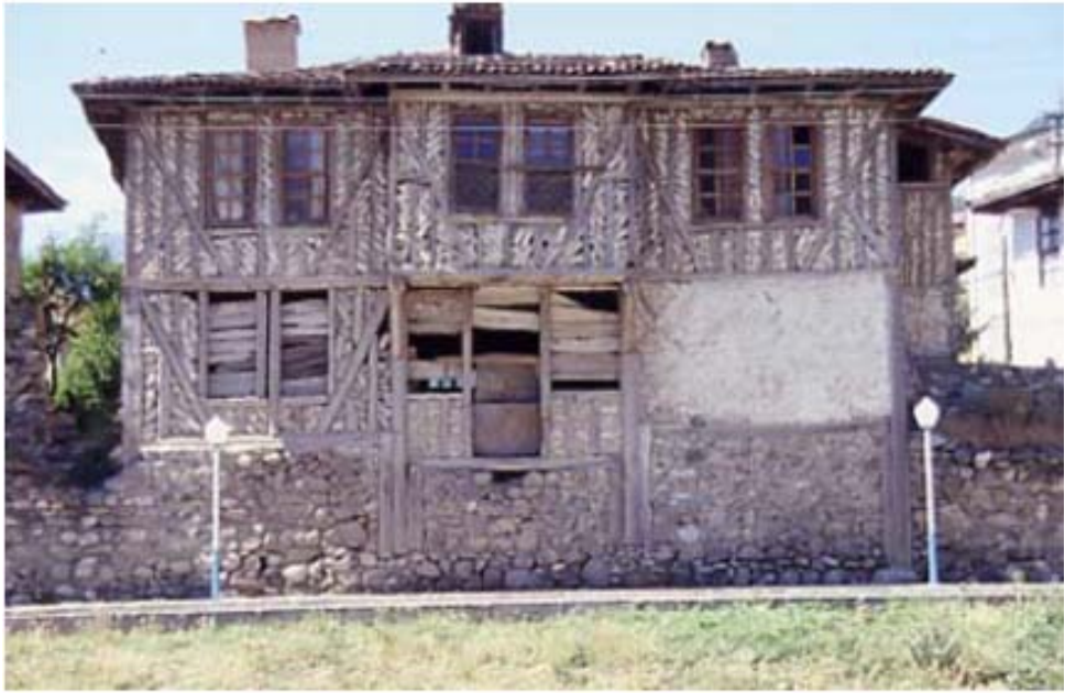
K.F. 7. 18. Çorum Hacıhamza Kale Mahallesi'nden Bir Örnek (İ. Erdem Ufuk, K. Kutgün Eyüpgiller)
