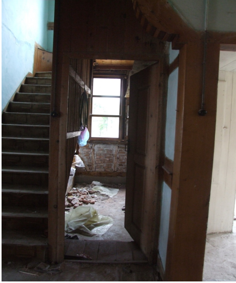
Foto 6.13. Merdiven Altındaki Depo (Katalog 1)
