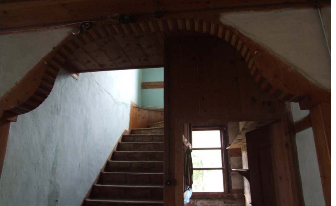
Foto 6.12. İkinci Kata Çıkan Merdivenler (Katalog 1)
