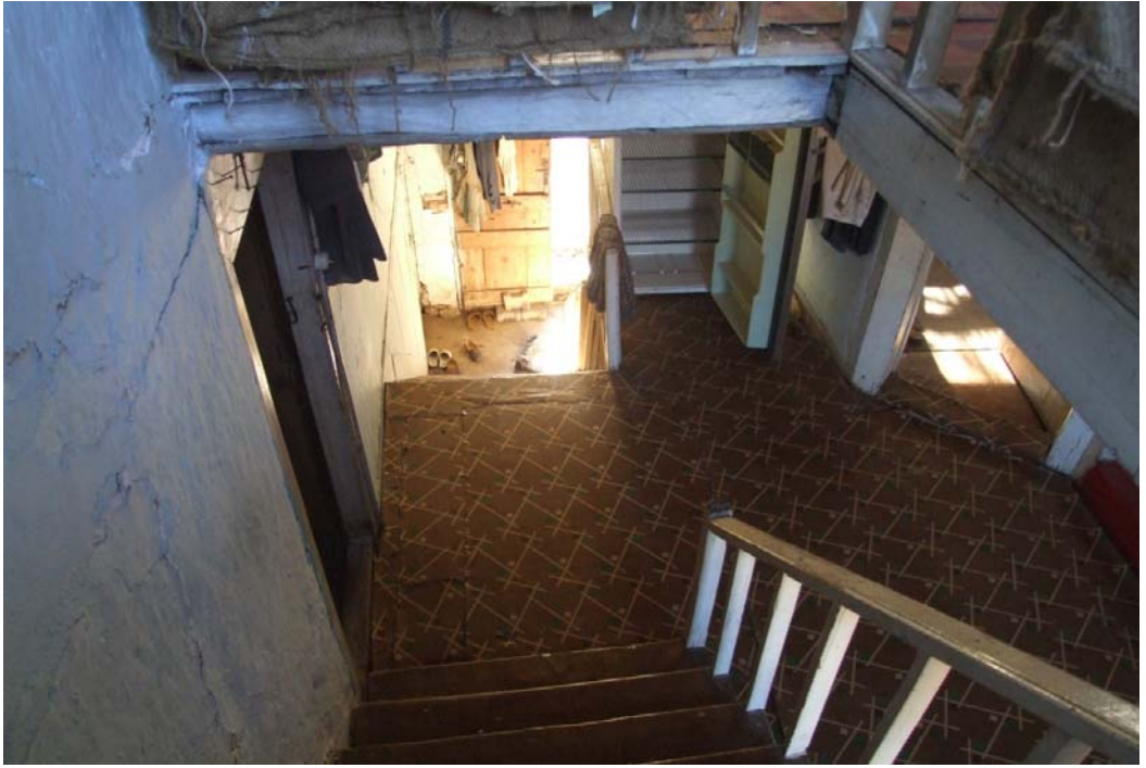
Foto 6.99. Sofadan Görünüş (Merdivenlerden Görünüş) (Katalog 7)
