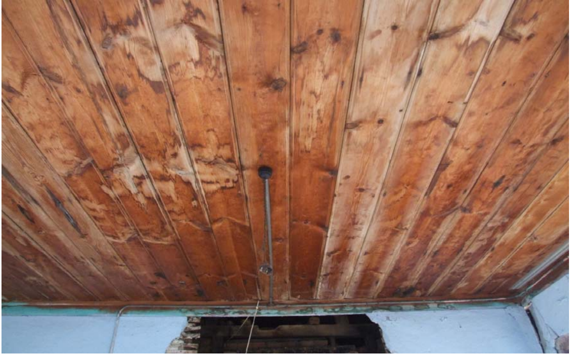
Foto 6.111. Güney Yönde Bulunan Odanın Tavanından Görünüş (Katalog 7)
