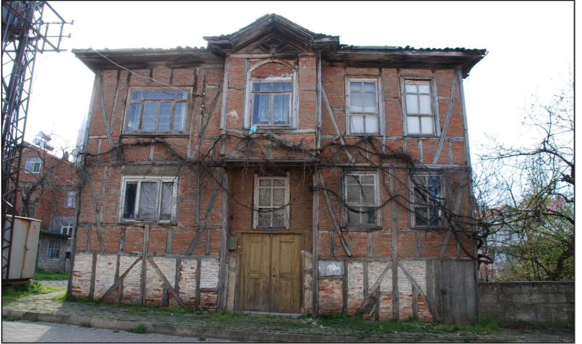
Foto 6.91. Güney Cephe (Giriş Cephesi) (Katalog 7)
