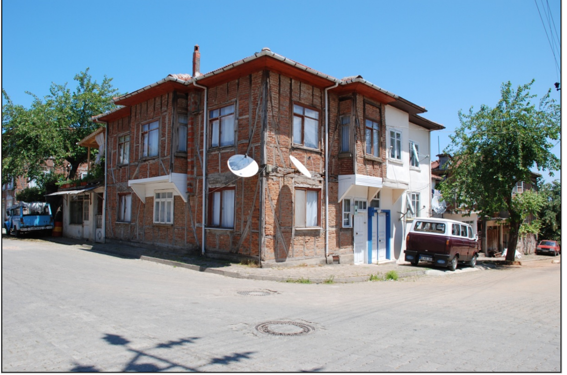
Foto 6.59. Güneydoğu Cepheden Görünüş (Katalog 4)
