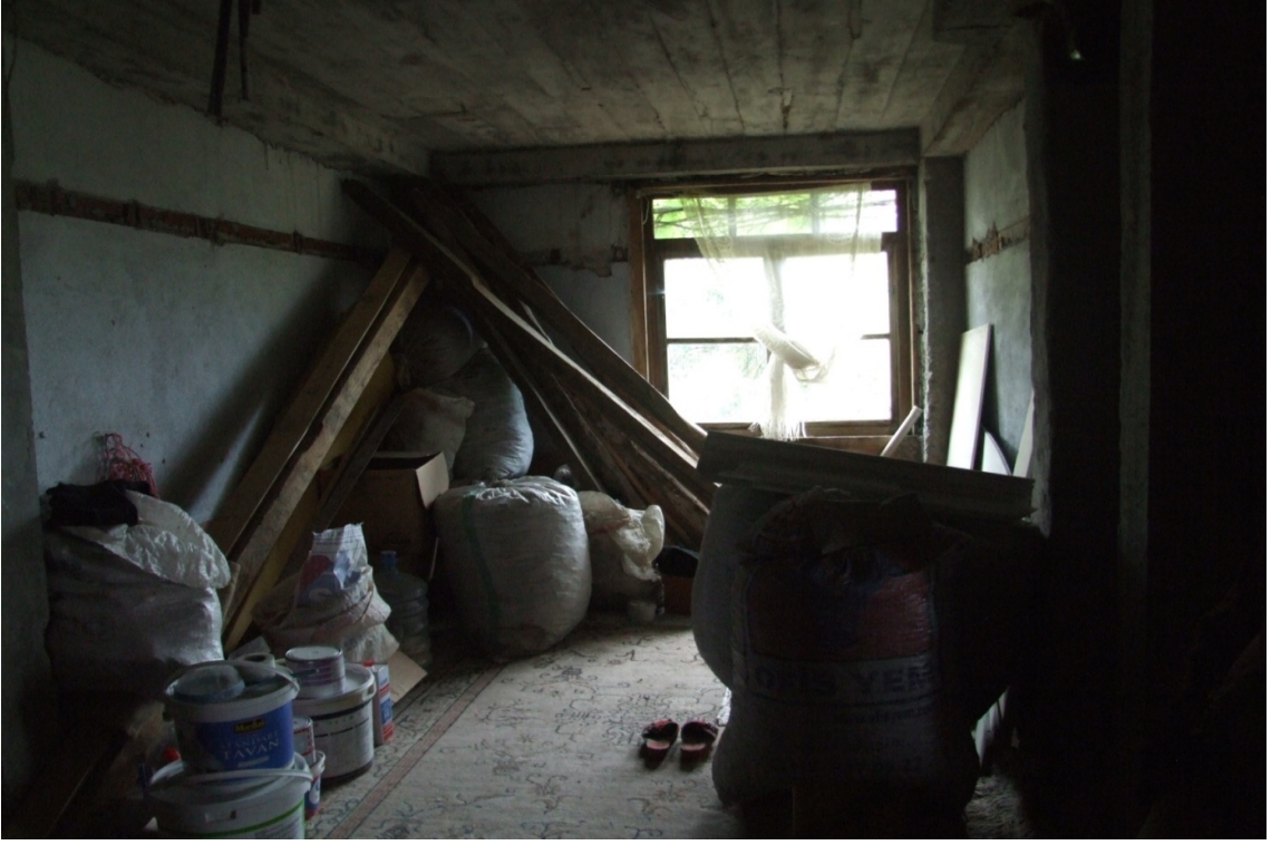
Foto 6.47. Zemin Kat Depodan Görünüş (Katalog 2)
