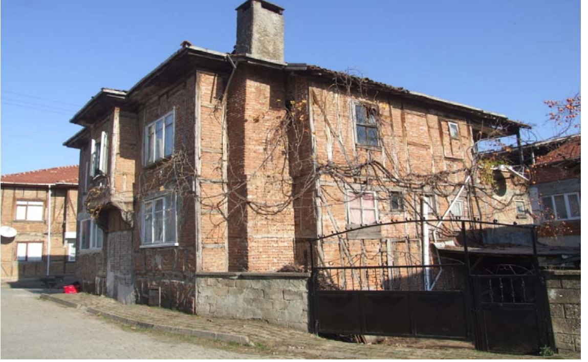
Foto 6.51. Güneydoğu Cepheden Görünüş (Katalog 3)
