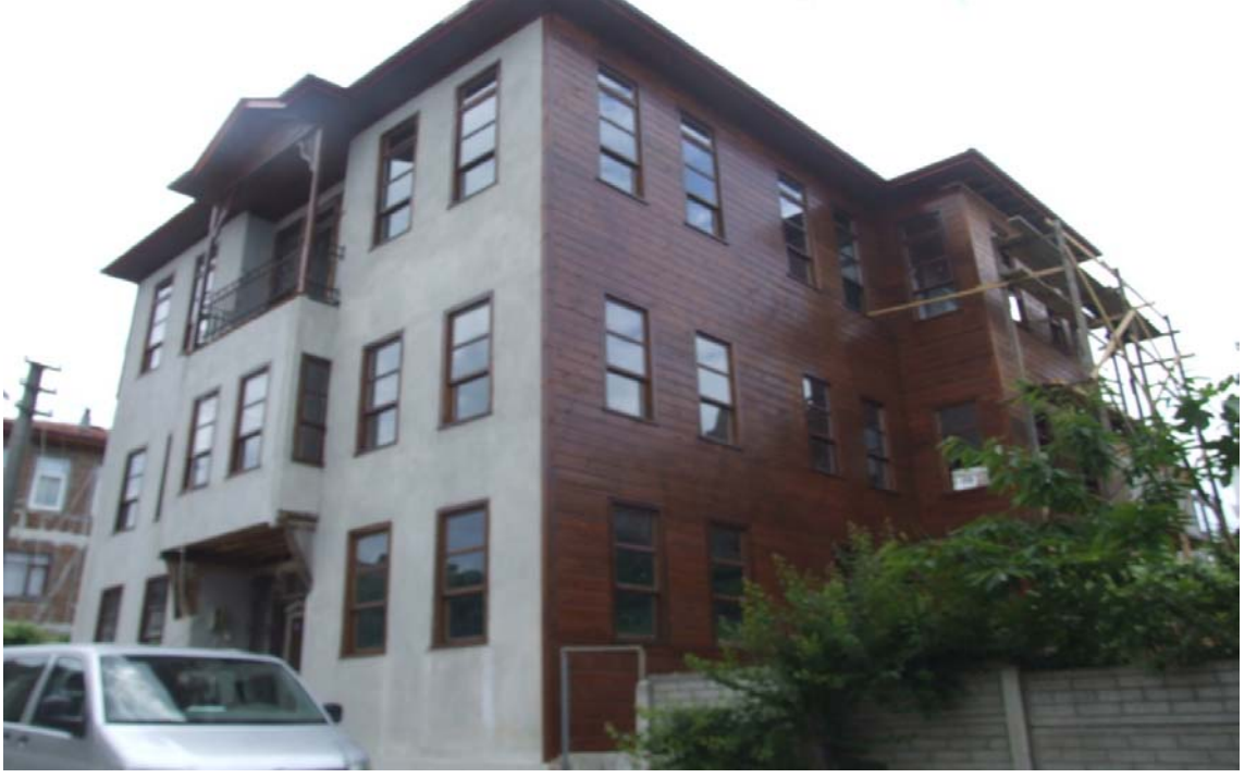
Foto 6.1. Kuzeydođu Cepheden Görünüş (Katalog 1)
