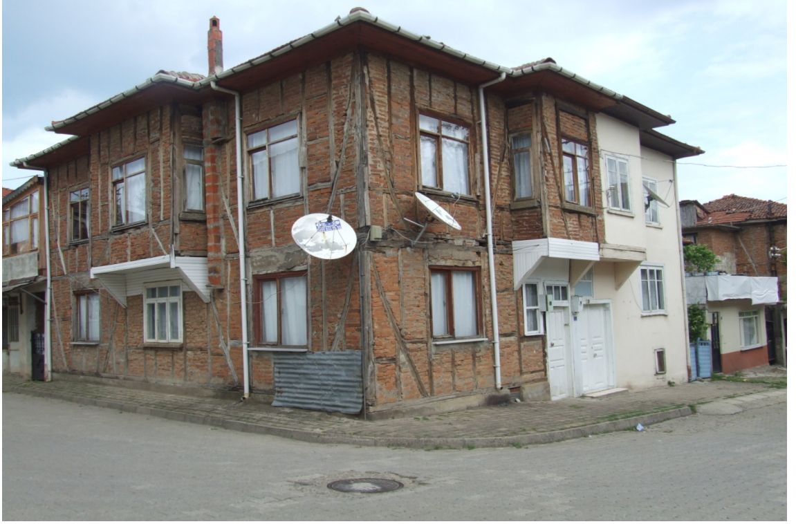
Foto 6.61. Güneydoğu Cephe (Katalog 4)
