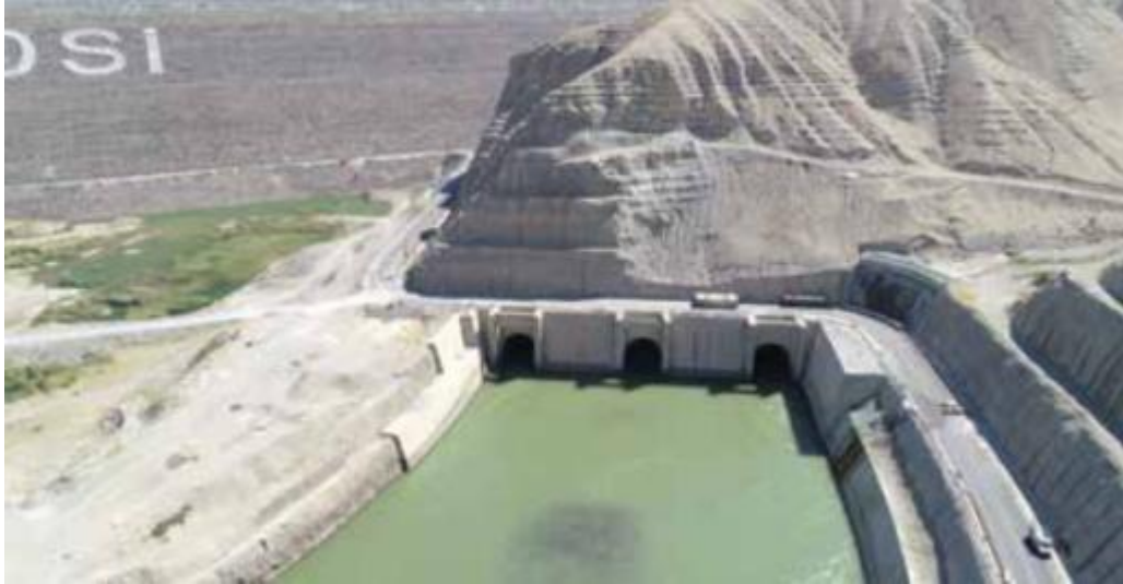
Şekil 13. Iısu Barajı derivasyon tünelleri
