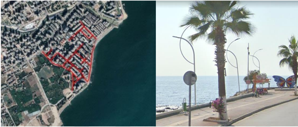
Şekil 6.3. Viranşehir Mahallesi Enerjisa Kurumu Aydınlatma Çalışması ve Sokak Aydınlatma Elemanı Örneği (Google Earth programından elde edilen görüntü üzerinden üretilmiştir.)
