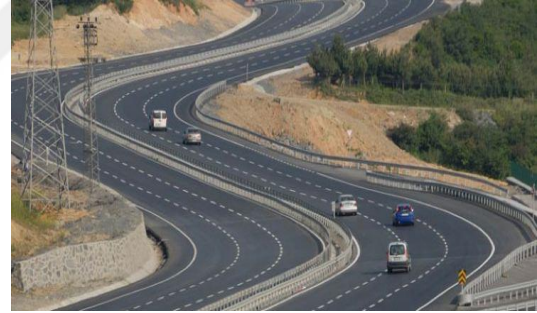
Şekil 3.3. Ters yerleştirilmiş yatay kurp ve birleşik kurp
