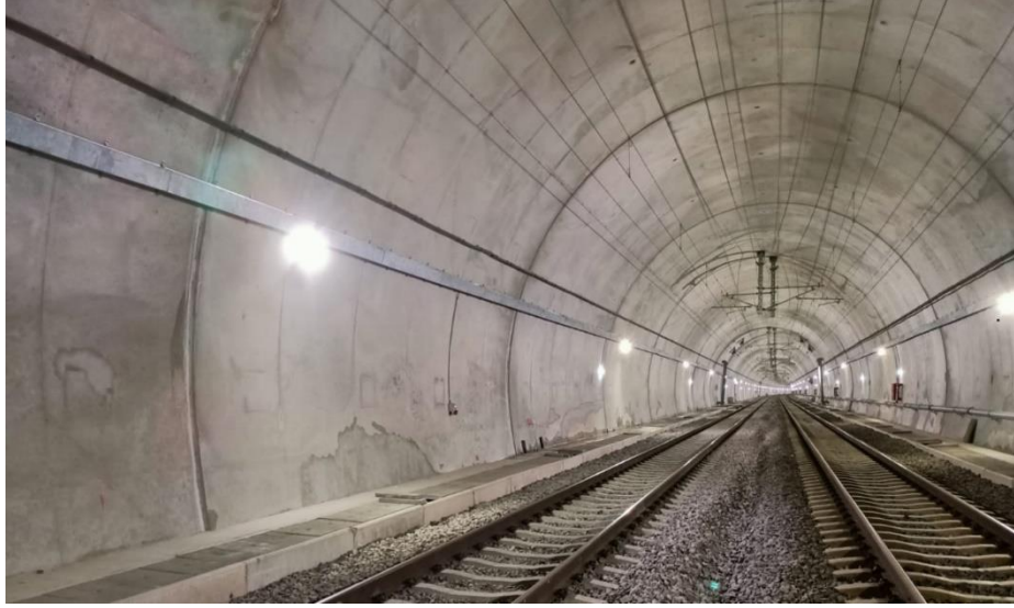
Şekil 4.9. Tünelde aydınlatma düzeyi ölçülen bölge
