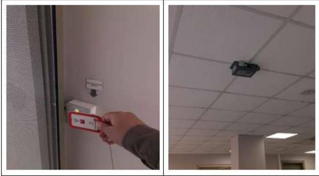
Şekil 4.13 : Firma wipilot personel takip sistemi sinyalizasyon kart okutma sistemi, sinyal dağıtıcı ve koordinatör sistemi.
