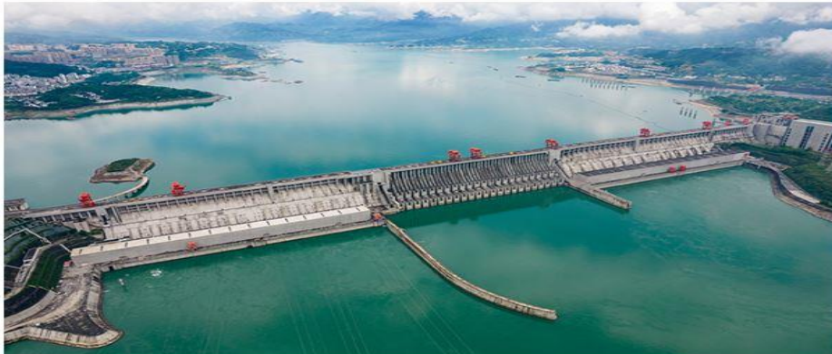
Şekil 3.7. Üç Boğaz Barajı
