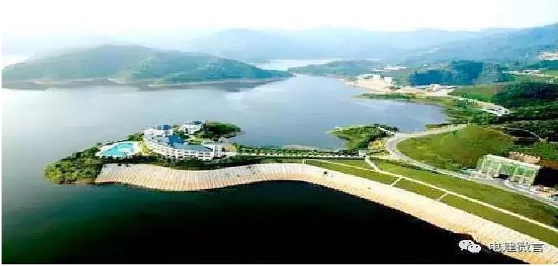
Şekil 5.1. Huizhou Pompaj Depolama Santrali
