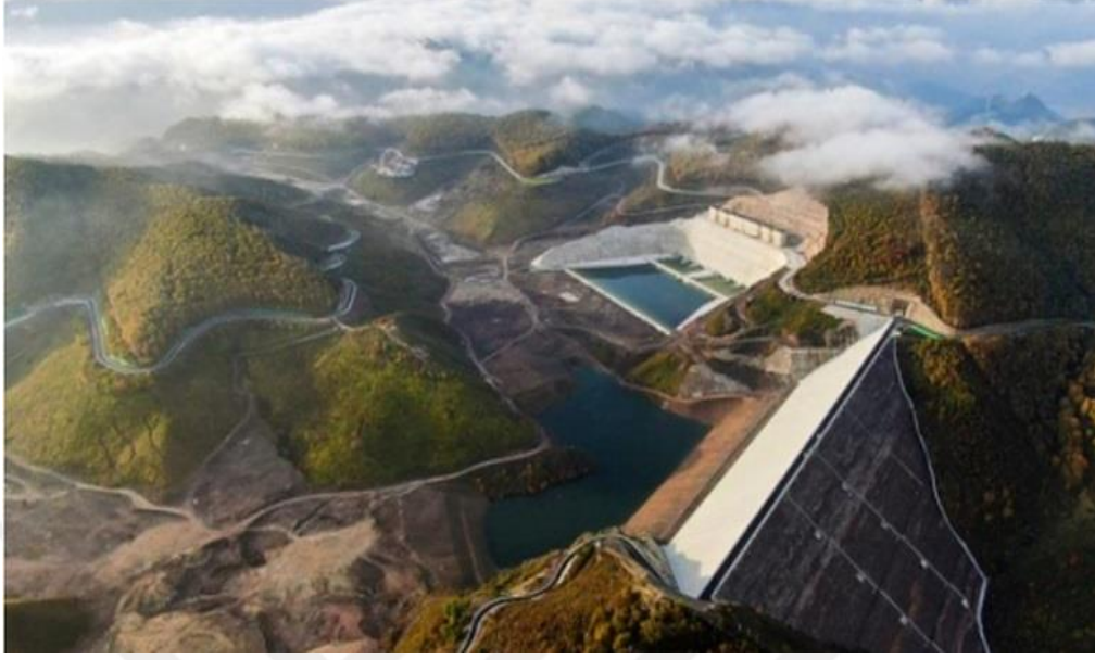
Şekil 5.3. Fengning Pompaj Depolama Santrali
