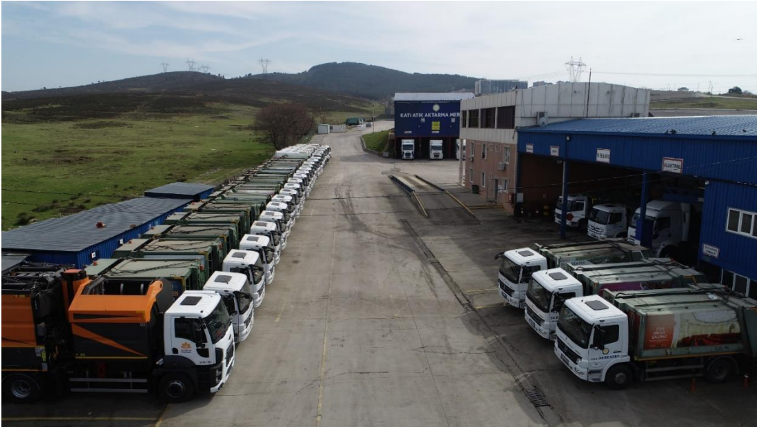
Şekil 4.17. Sultanbeyli Belediyesi Katı Atık Aktarma Merkezi
