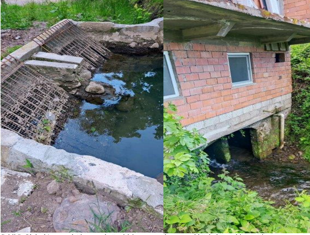
Şekil 5. Oluktaki suyun değirmene aktığı girişi ve suyun dışarıya atıldığı bölümün bir örneği.
