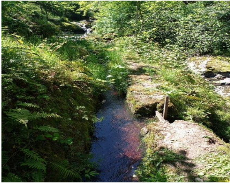
Şekil 4. Oluk (hark, bent) denilen su kanalı ve kesecek (savak) örneği.
