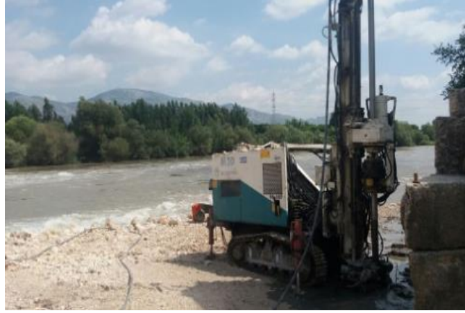
Resim 2.11 Enjeksiyon yöntemi ile zemin iyileştirme (İnt. Kayn. 7).
