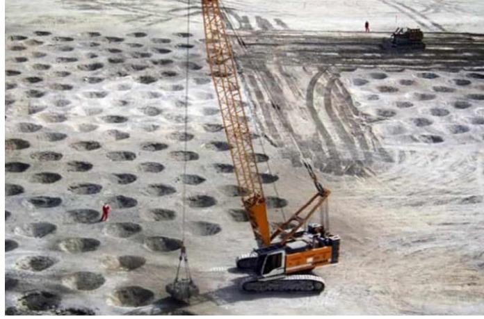
Resim 2.8 Derin kompaksiyon yöntemi ile zemin iyileştirme (İnt. Kayn. 6).
