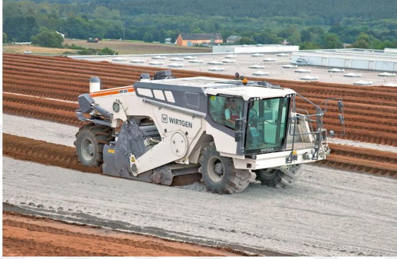
Resim 2.5 Kireç ile zemin iyileştirme yöntemi (İnt. Kayn. 4).
