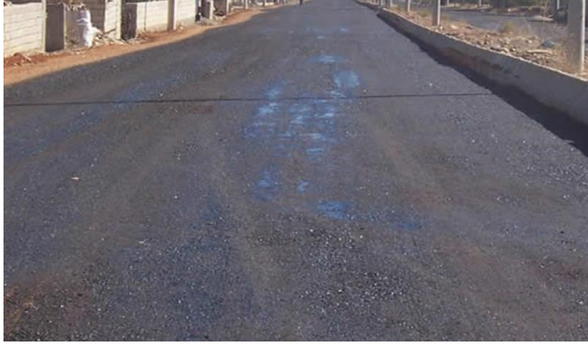
Resim 2.6 Bitüm ile zemin iyileştirme yöntemi (İnt. Kayn. 5).
