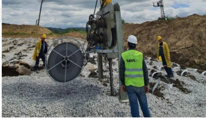
Resim 2.3 Drenaj yöntemi ile zemin iyileştirme (İnt. Kayn. 3).
