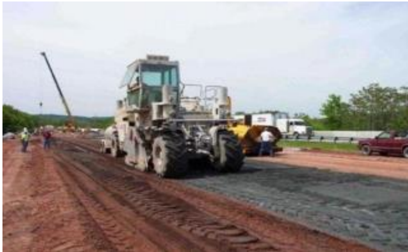
Resim 2.7 Uçucu kül ile zemin iyileştirme yöntemi (Çetin 2011).
