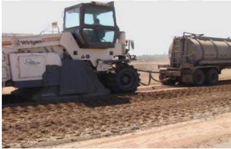
Resim 2.4 Çimento enjeksiyonu ile zemin iyileştirme yöntemi (Çetin 2011).
