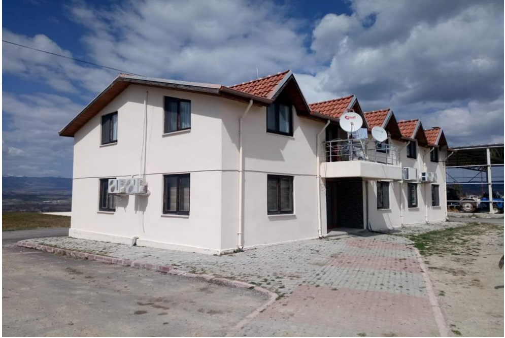
Şekil 3.24 : Taşköprü Orman İşletme Müdürlüğü yangın ekip binası.
