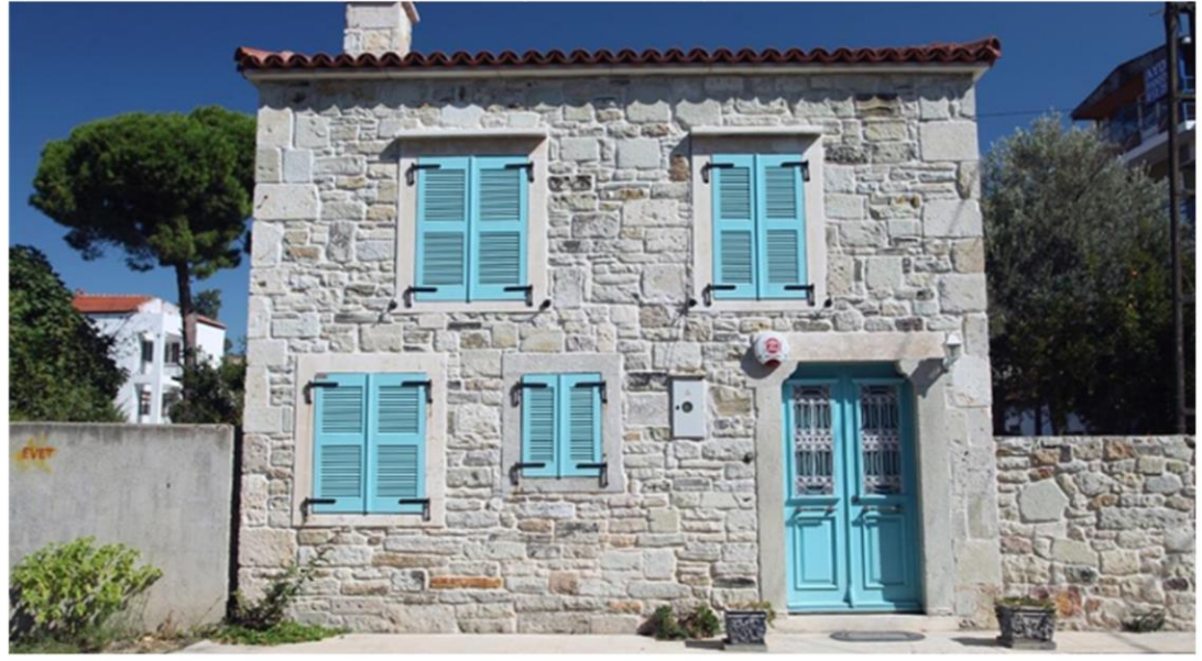
Şekil 3.17: Donatısız yığma taşıyıcı duvarlı bina örneği (Url 16).
