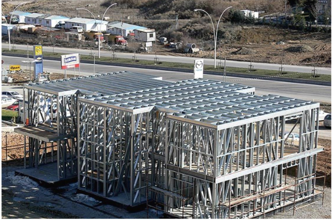
Şekil 3.5: Çelik moment çerçevesi bina örneği (Url 5).
