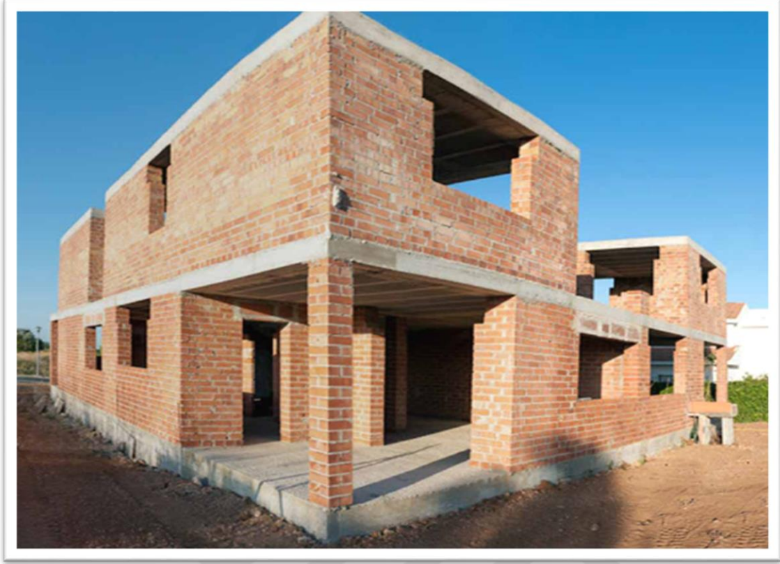
Şekil 3.12: Takviyesiz yığma dolgu duvarlı beton karkas bina örneği (Url 12).
