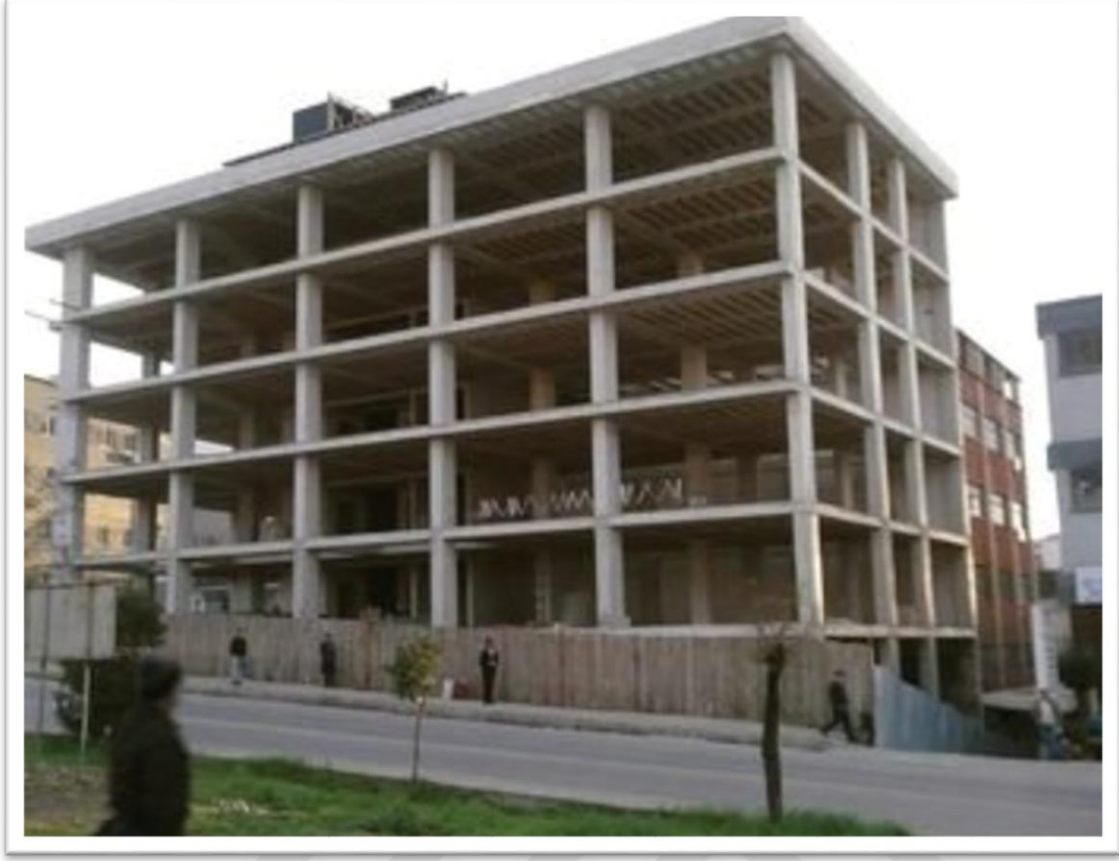
Şekil 3.10: Betonarme moment dayanımlı çerçeveli bina örneği (Url 10).
