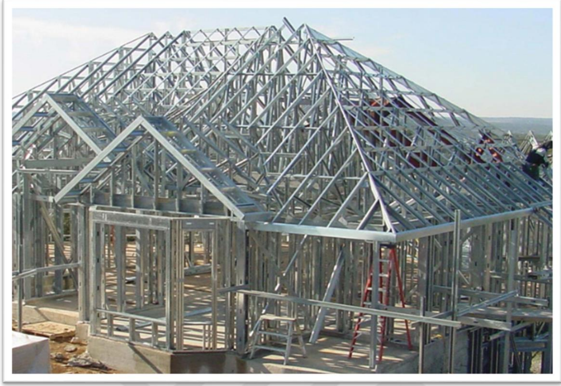
Şekil 3.6: Çelik çapraz çerçevesi bina örneği (Url 6).
