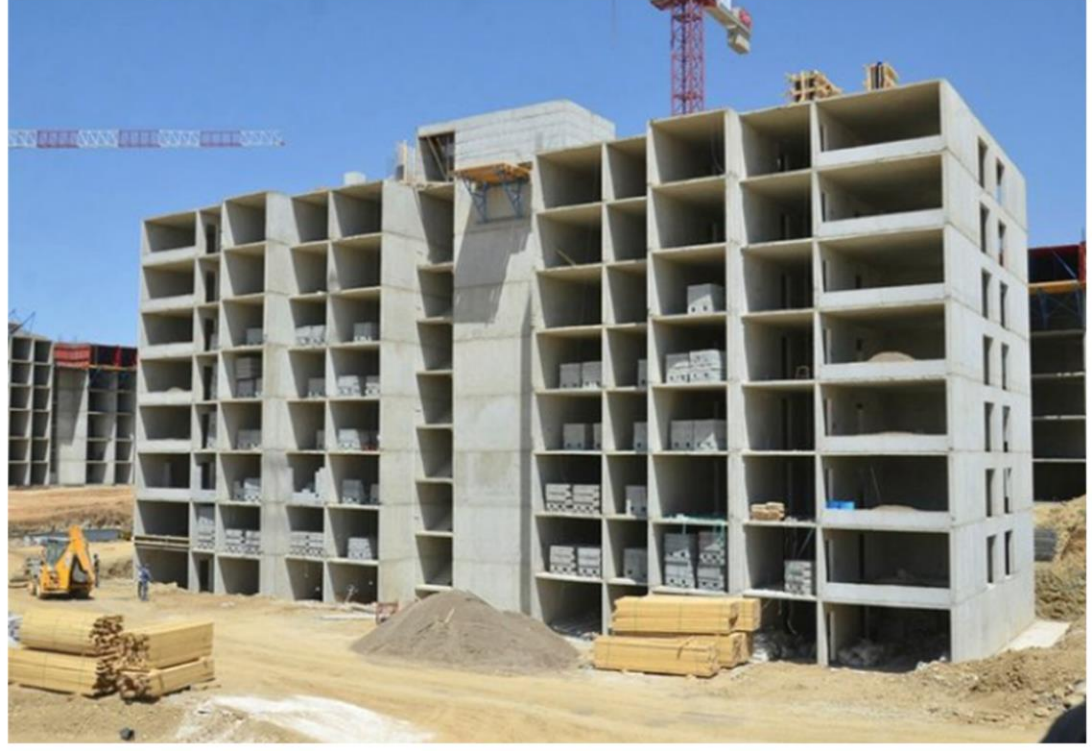
Şekil 3.11: Beton perde duvarlı bina örneği (Url 11).
